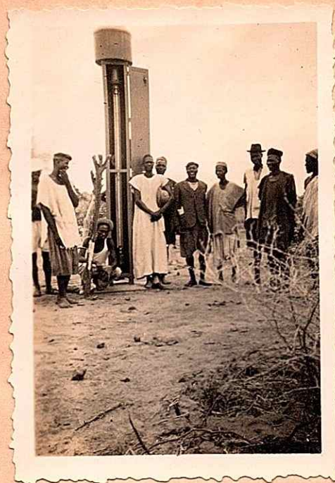
Pluviomètre totalisateur de GOURDASSY
