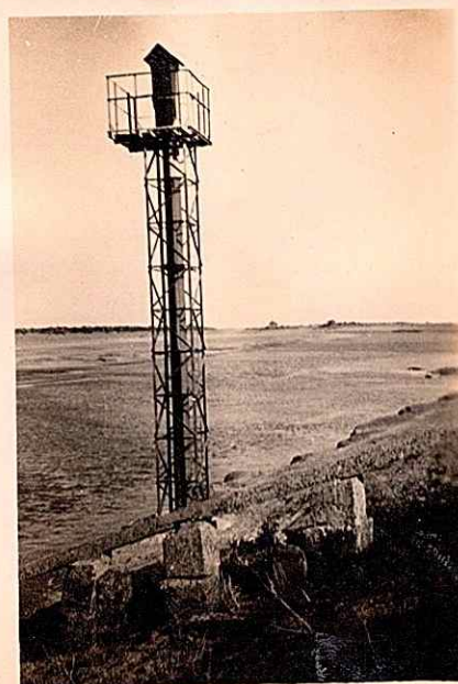
Limnigraphe de DIOULDE-DIABE (Au premier plan la vieille échelle hors service)
