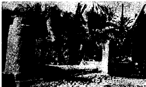
FIGURE 39. - Coffrage et cheminée du fourneau servant à faire cuire les dattes jaunes et dures ( kalâl ) qui deviendront ainsi des fruits de bonne conservation ( kalâl matbouk ou salouq ). Les quatre piliers soutiendront une couverture de nattes destinée à empêcher la suie et les cendres de tomber dans le chaudron. Côte Baatina, Mascate.
