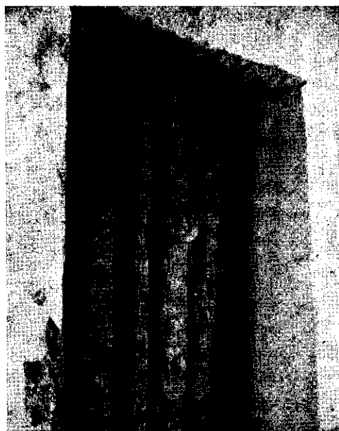
FIGURE 1. — Porte en bois de palmier-dattier. Les planches sont souvent assemblées au moyen non de clous mais de lanières de cuir de chameau. Ghadamès, Libye.
