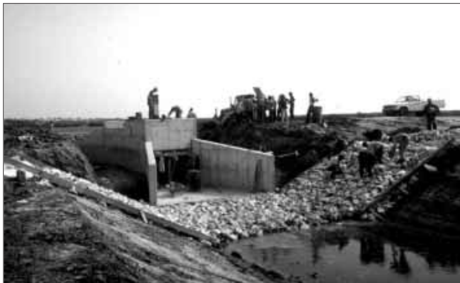
Photographie 5 : Construction de l'ouvrage de Lekser. Il s'agit d'un des deux ouvrages ajoutés au schéma initial sur la base des conseils des pêcheurs locaux.
