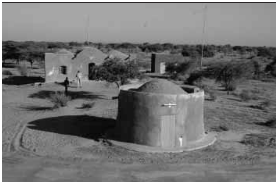
Photographie 3 : Le siège du parc, exemple de « construction sans bois » au Sahel.
