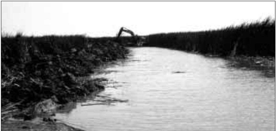
Photographie 9 : En 1998, l'entrée de l'ouvrage de Cheyal a été débarrassé des plantes envahissantes par une pelle mécanique amphibie.
