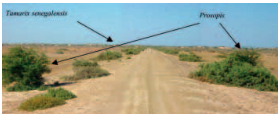
Photographie 25 : Plusieurs années après, au pied de la digue la colonisation par les Tamarix est réussie et constitue une protection contre le batillage. En revanche, des Prosopis juliflora (au premier plan) se sont aussi développés et devront être détruits car leurs racines risquent d'endommager la digue.
