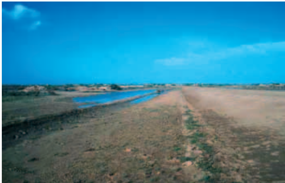
Photographie 24 : La digue de Lekser en 1998, vue depuis la dune de Ziré en direction de l'ouest vers la dune côtière. Un système de tranchées et de levées coupe-vent a été installé pour favoriser l'accumulation de l'eau et l'implantation de Tamarix senegalensis
