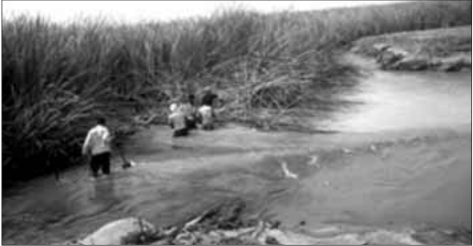
Photographie 8 : En 1997, Typha domingensis a été enlevé à la main à l'entrée de l'ouvrage de Cheyal afin d'augmenter les débits vers le bassin du Diawling.
