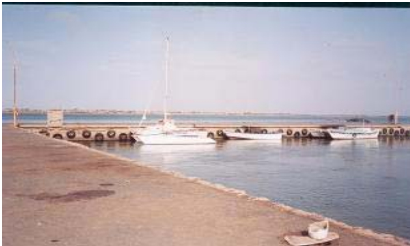
Photo 8.- Les installations du port des polonais. Cliché : M M Camara, juillet 2004
