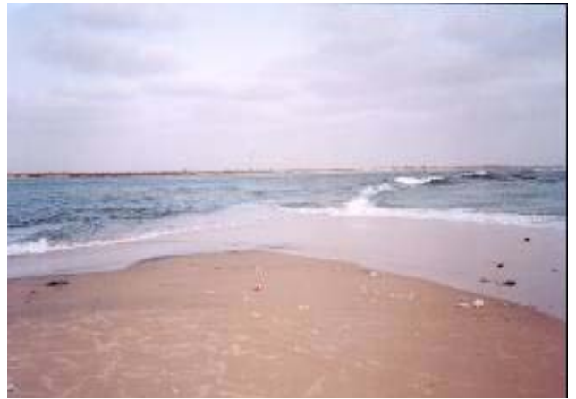
Photo 11a et 11b.- L'élargissement du canal de délestage, juin 2004. Cliché : M M Camara
