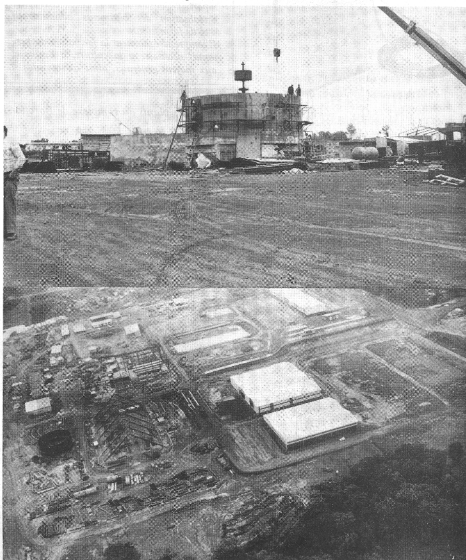
Le chantier de construction du complexe de Borotou en avril 1978.
