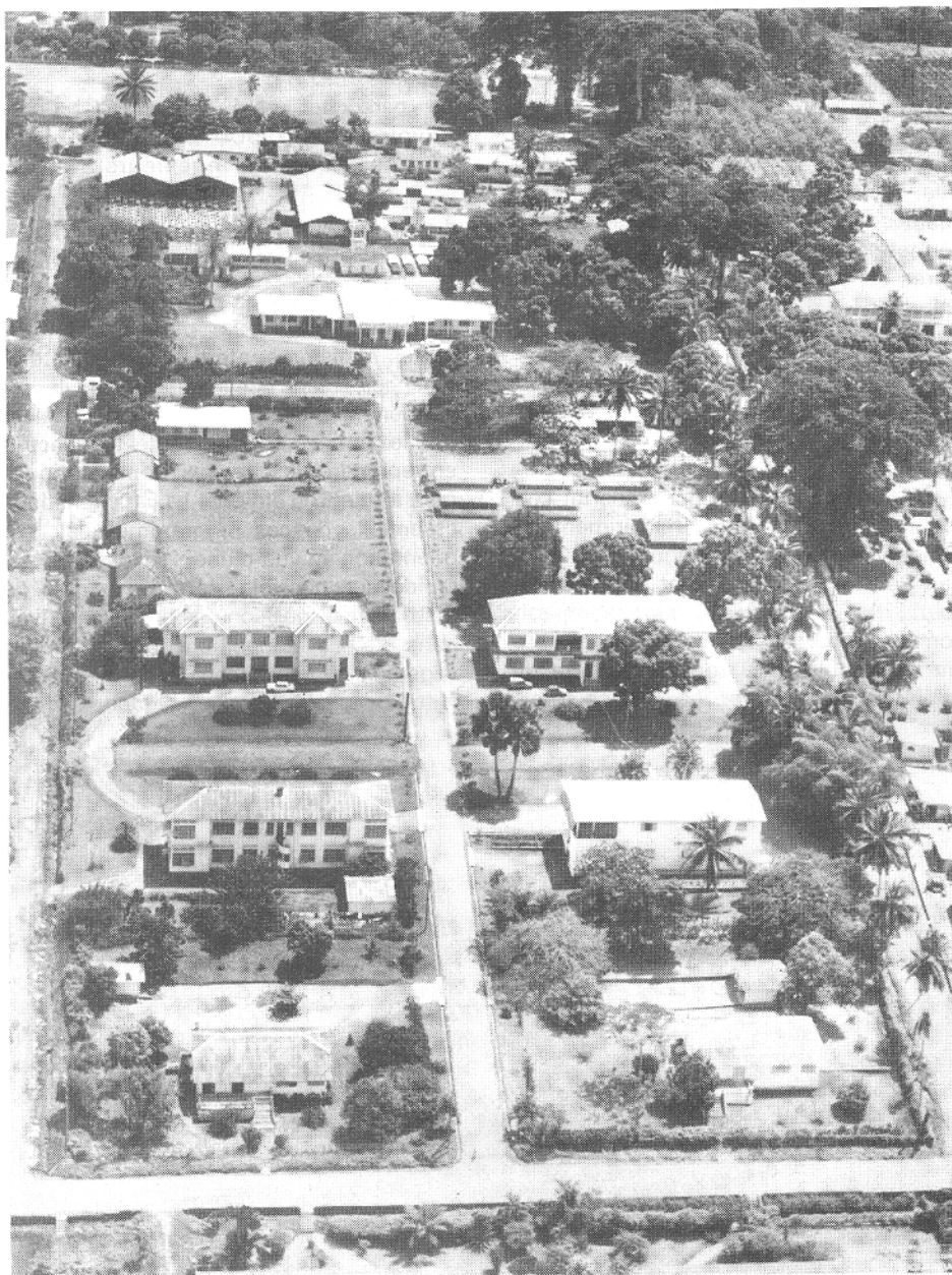
Centre de Bingerville : vue générale des laboratoires.
