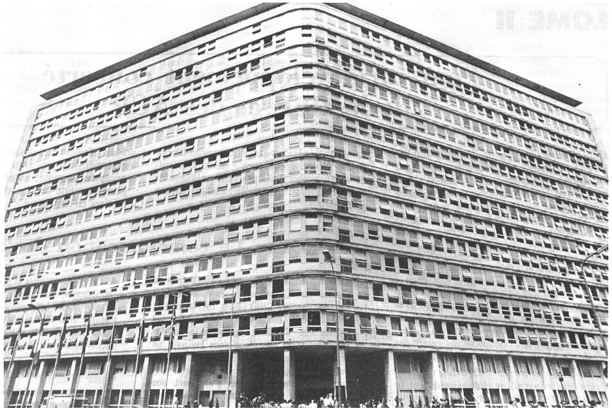
BATIMENT CHARLEMAGNE DE LA CEE A BRUXELLES
