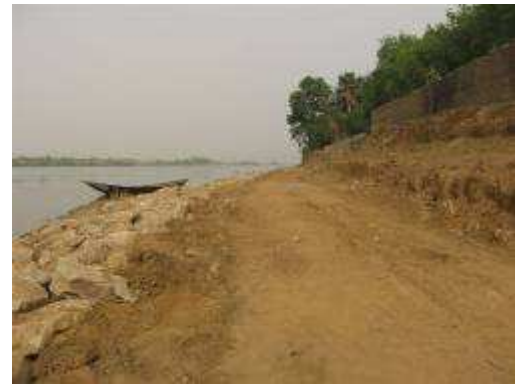
Photo 7 et 8 : Enrochement de fondation sur lit - Kayes et enrochement de protection en berges-Kayes
