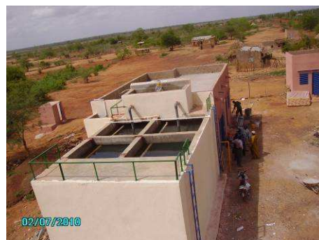
Photo 32 et 33 : Intérieur de la station, filtres et vue de la station de Mahinanding (Sénégal)
