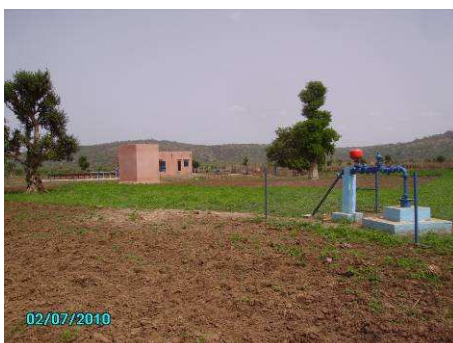
Photo 34 : Vue du forage de Sélinkégny (Mali)
