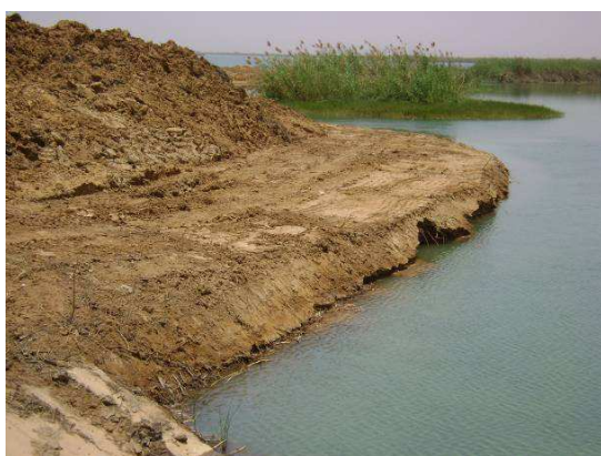
Photo 22 et 23 : Plateforme d'accès en remblai de matériaux réutilisables à Ronkh (Sénégal) et faucardage du Laoueija (Mauritanie)
