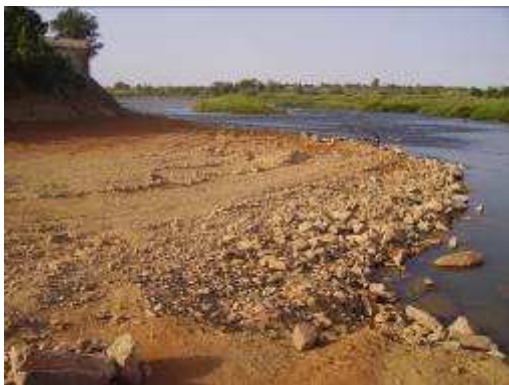
Photo 7 et 8 : Enrochement de fondation sur lit - Kayes et enrochement de protection en berges-Kayes
