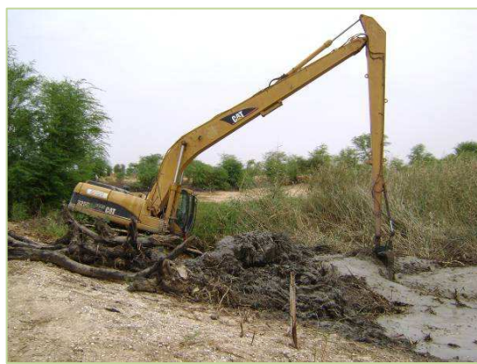
Photo 22 et 23 : Plateforme d'accès en remblai de matériaux réutilisables à Ronkh (Sénégal) et faucardage du Laoueija (Mauritanie)
