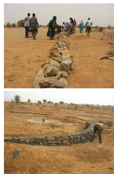
Photo 43, 44 : Ouvrages antiérosifs (cordons pierreux et demi-lune) dans le Papparrah, Mali
