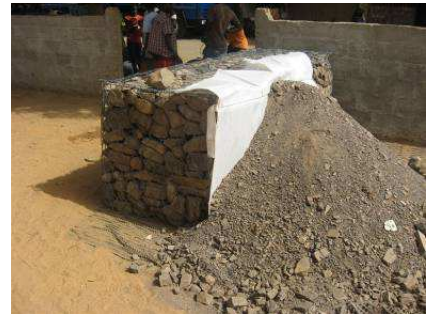
Photo 45 : Modèle de gabion avec remblai renforcé réalisé à Kayes, formation du personnel (Mali)
