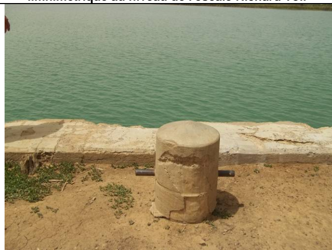
Figure 23: Bitte d'amarrage sur le quai
