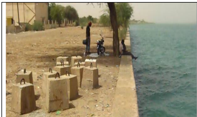
Figure 18: Corps morts au niveau de l'escale Richard Toll
