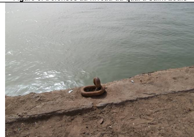
Figure 8: Organeau au niveau du quai
