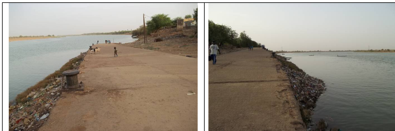
Figure 38: Quai au niveau de Matam
