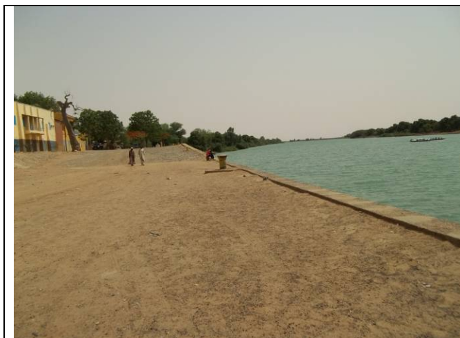
Figure 33: Quai à 2 niveaux
