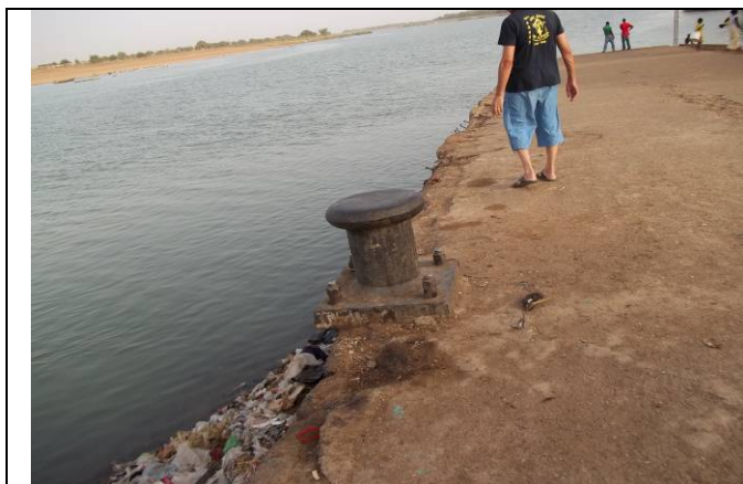
Figure 41: Bollard et poutre de couronnement
