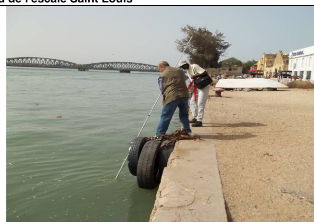
Figure 6: Défenses au niveau du quai à Saint Louis
