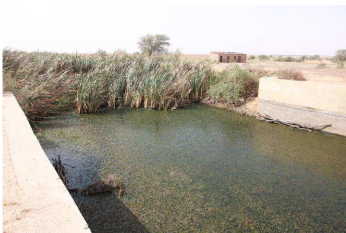
Figure 22 : Eau stagnante à la station de pompage de Ndiâél.
