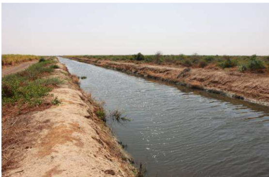
Figure 8 : Canal de collecte des eaux de drains traitées et non traitées (rejet X6)
