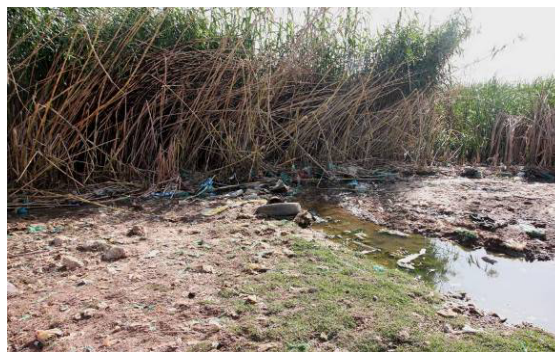
Figure 3 : Exutoire des eaux pluviales de Rosso
