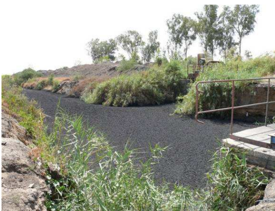
Figure 10 : Lagunage d'eaux de drains de CSS (premier bassin)
