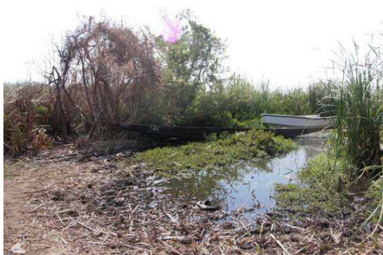
Figure 12 : vue de la prise d'eau AEP sur le lac du village de Mbane.
