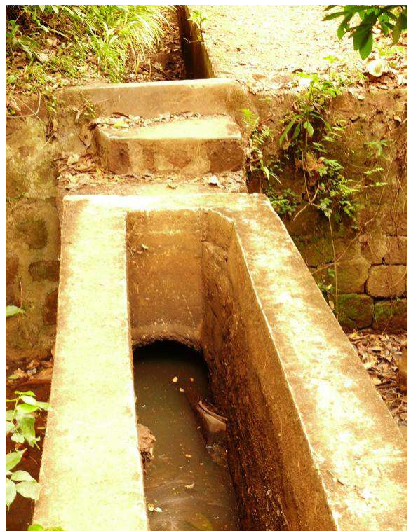
Figure 20 : pont canal à l'aval du barrage de Tolo (ouvrages abandonnés).
