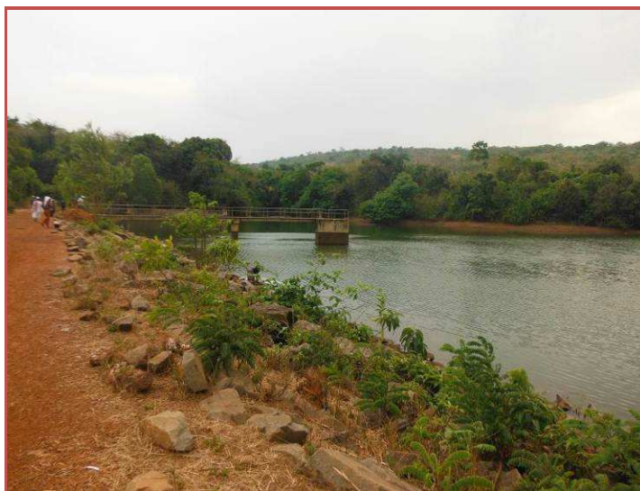
Figure 13 : barrage réserve du Bafing
