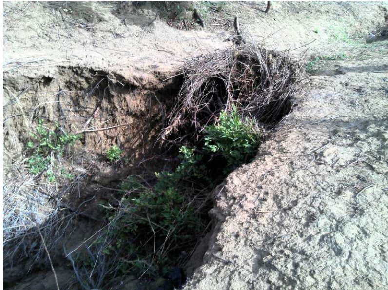
Photo 5: Erosion en rigole à partir du Bakoye et allant directement vers le village de Babaroto
