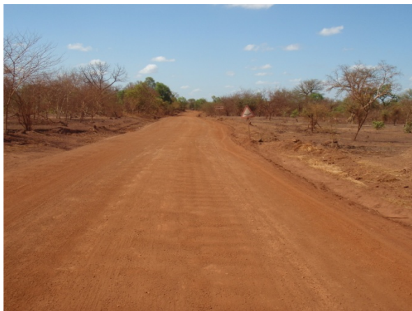
Photo 8-1 Route des mines - Tronçon Kayes-Sadiola (Juin 2010)
