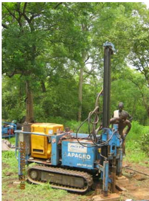
Foreuse APAFOR en position sur FC-10-07
