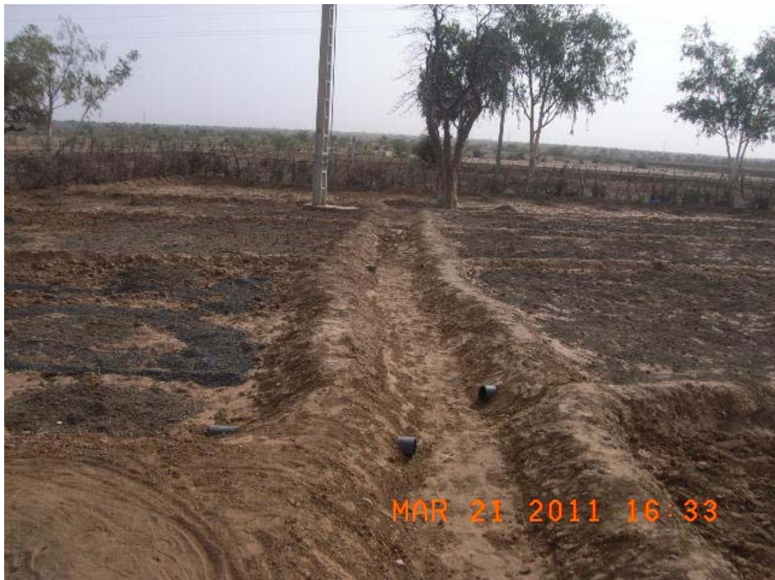
Photo 7 Arrangement pour distribution aux parcelles
