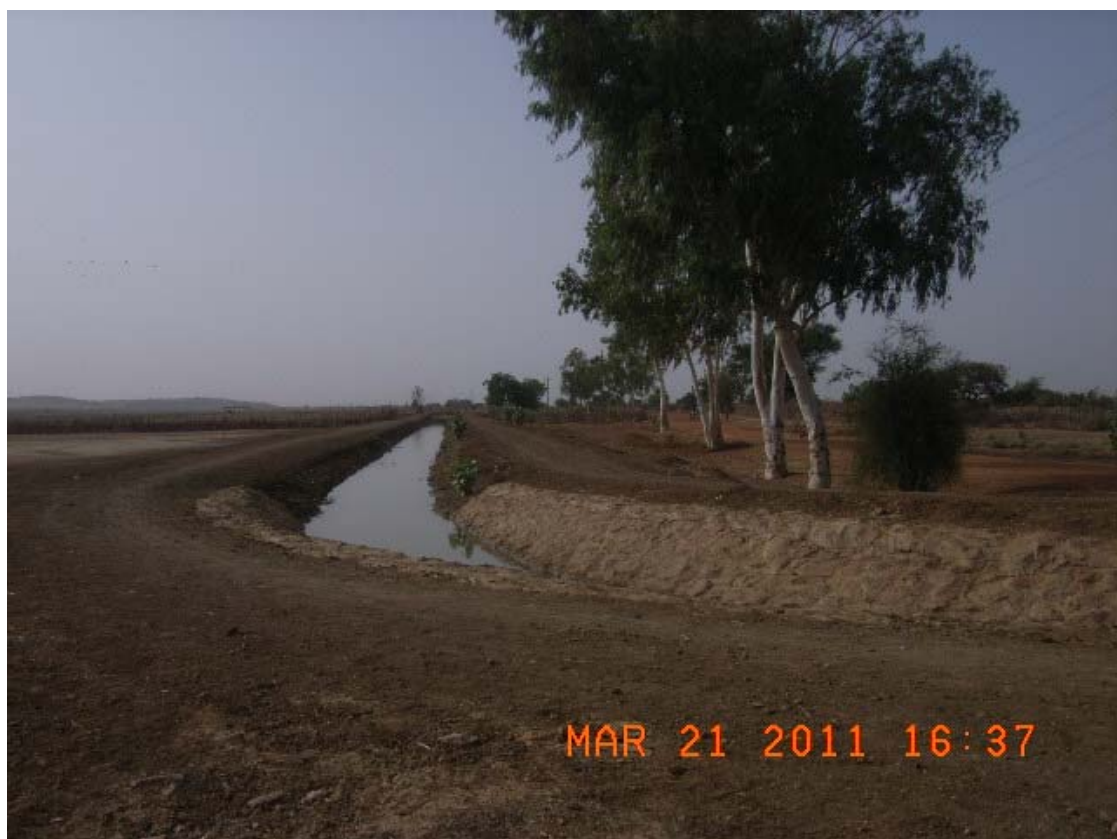
Photo 6 Exemple d'un canal en terre avec prélèvement du fleuve Sénégal
