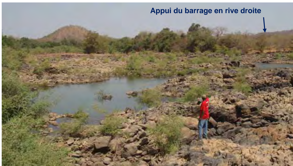
Photo 4 Vue amont vers l'axe du barrage (3 mars 2011)
