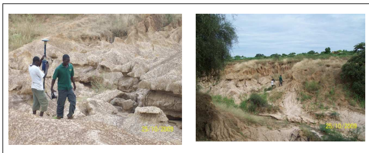
Photo 22 : Lève topographique de zone de dégradation avec des ravins site Ambidedi
