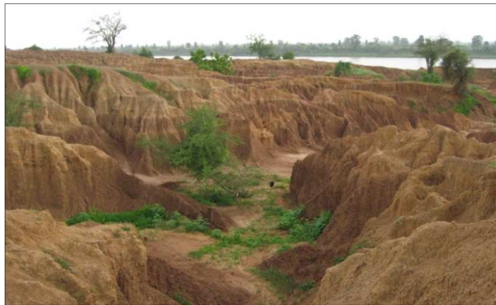
Photo 2 : Forme de Dégradation en ravines (site de Samé Wolof)
