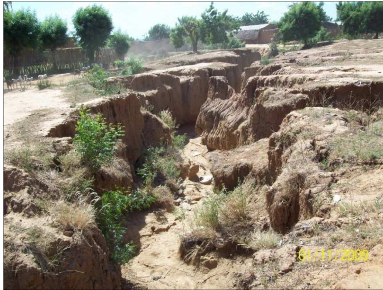
kPhoto 13 : Dégradation en ravins et en griffes profondes dans le village de Diakalel
