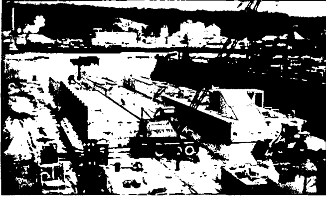
Fig. 7.8: Construction dans un radoub - Port de Bremerton
