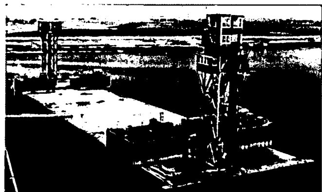
Fig. 7.15: Caisson en flottaison avec tours de visualisation, EM1110-2-2611, page C-9)
