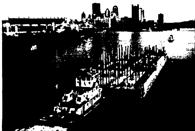
Fig. 7.3: Transport de la fondation du barrage de Braddock par flottaison
