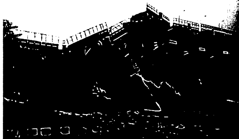
Fig. 5.9(b): Effondrement d'un barrage suite à une rupture de sa fondation
