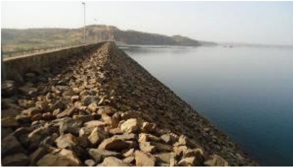
Vue détaillée du barrage en enrochements coté amont
