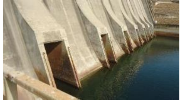
Détail des pertuis de demi-fond en sortie aval (nb 7)
