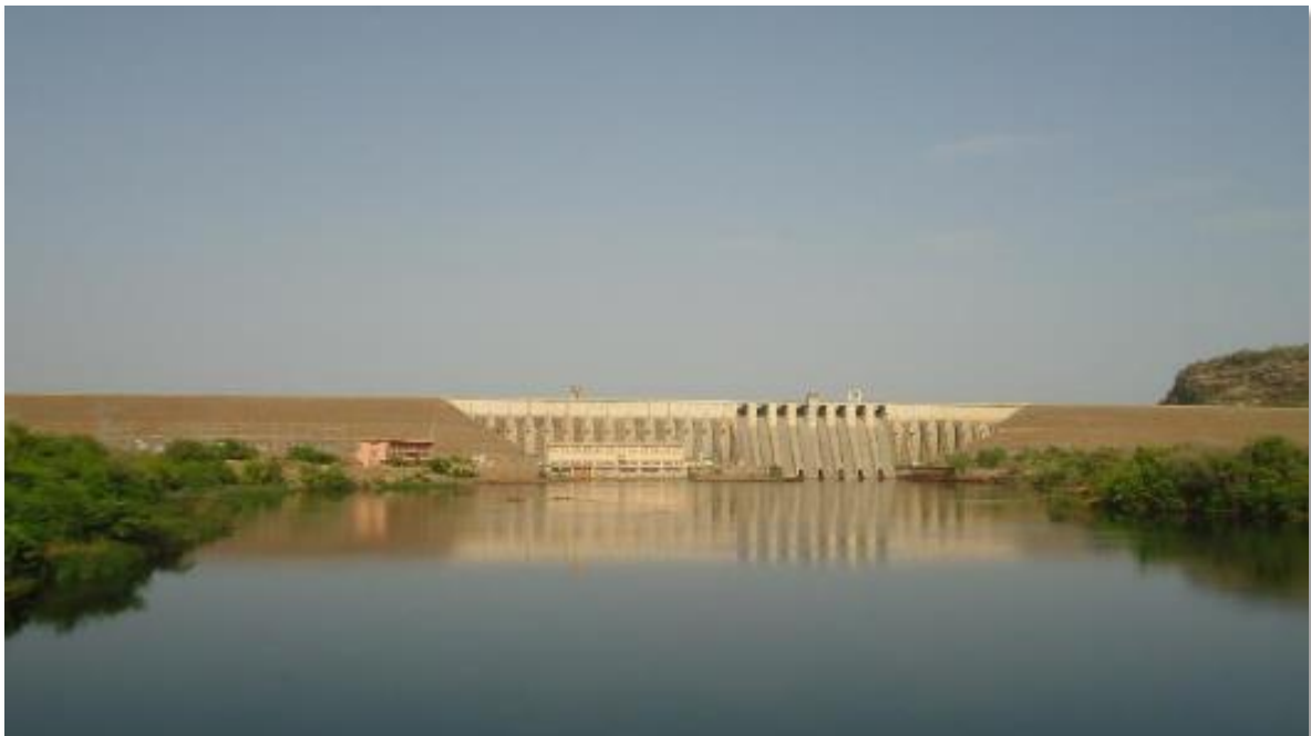
Figure 19 : Vue d'ensemble de l'ouvrage vu d'aval
