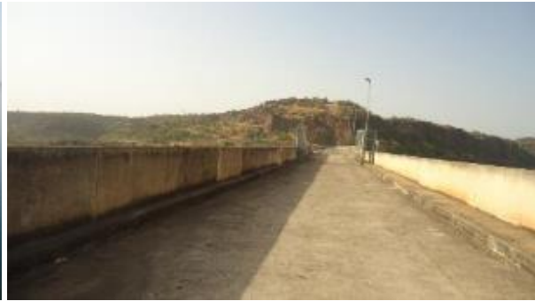
Vue rapprochée de la crête de l'ouvrage
