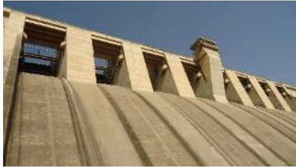
Détail des ouvrages déversoirs vannés en crête de barrage (nb 7)
