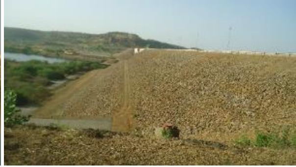
Vue rapprochée de la partie aval d'un des épaulements de type barrage zoné en enrochements
