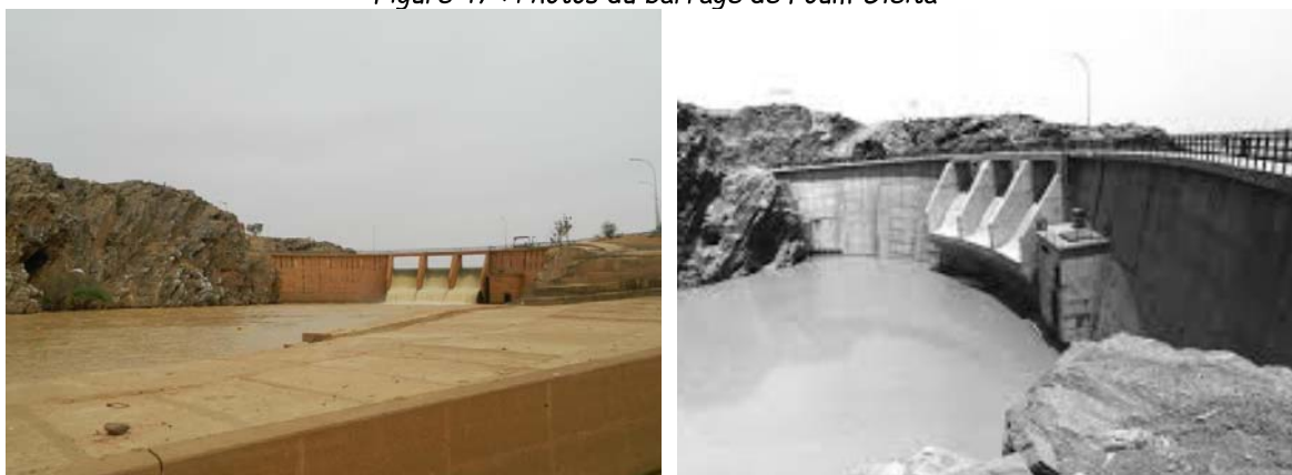
Figure 47 : Photos du barrage de Fom-Gleïta
