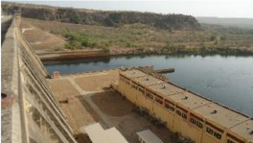
Figure 27 : Vue de l'usine hydroélectrique implantée au pied aval rive droite du barrage de Manantali
