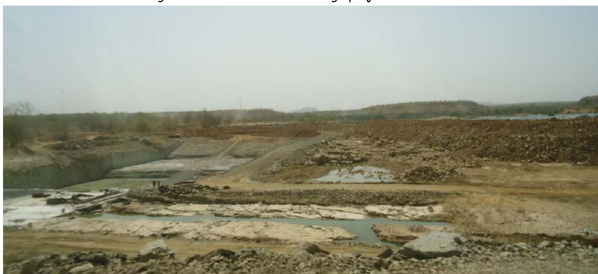
Figure 69 : Photo des travaux du barrage de Gouina
