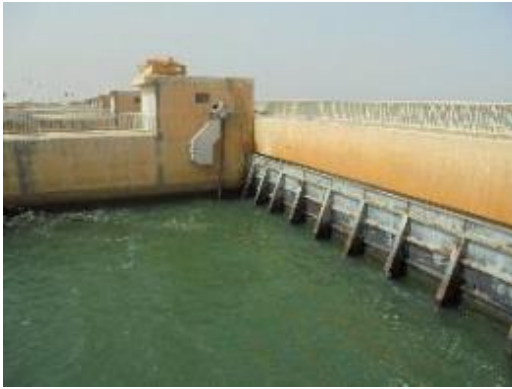
Vue partielle du tablier d'une vanne segment en position partiellement relevée
