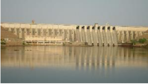
Vue aval de la partie centrale du barrage, de type barrage poids béton à contreforts, avec l'usine hydroélectrique au premier plan
