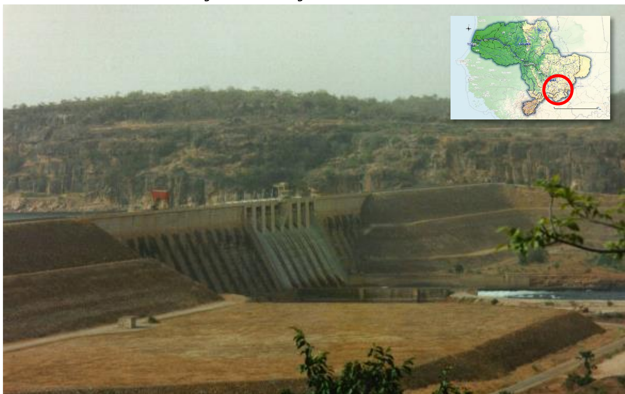
Figure 6 : Le barrage de Manantali
