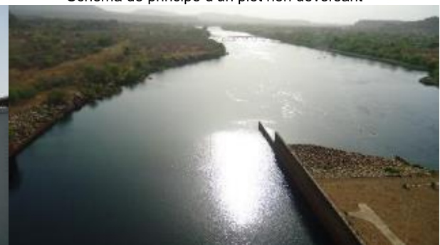
Détail du chenal de fuite à l'aval des ouvrages évacuateurs de crues
