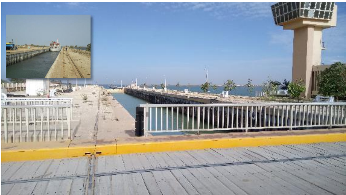
Figure 38 : Vue générale du sas de l'écluse du barrage de Diama en direction de l'aval
