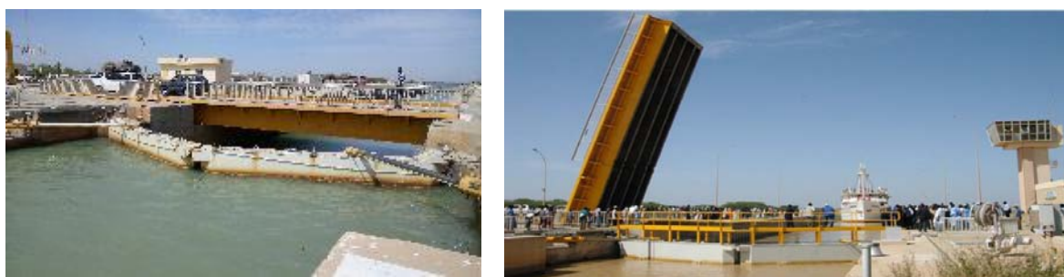
Figure 39 : La porte busquée amont et le pont levant franchissant l'écluse, en position baissée en levée
