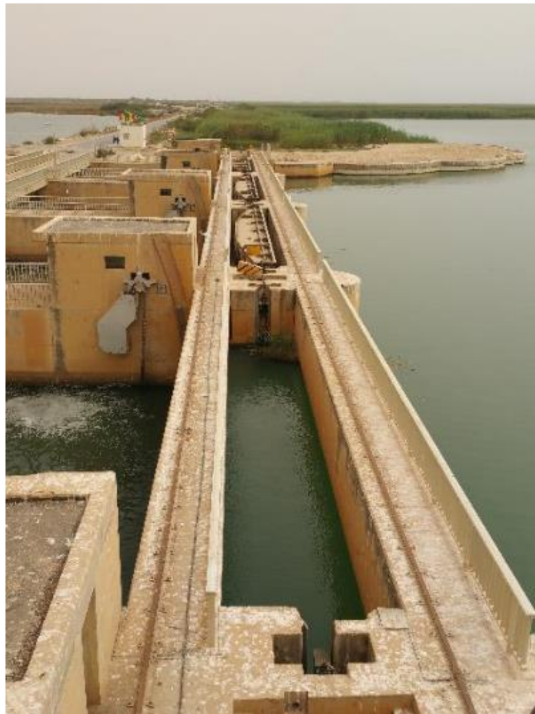
Figure 35 : Vue générale du barrage mobile prise dans l'axe de son chemin de roulement amont. À l'horizon : la Mauritanie
