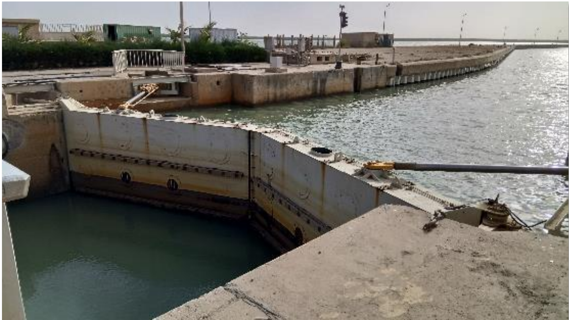
Figure 37 : Vue détaillée de la porte busquée amont (photo prise vers l'amont)
