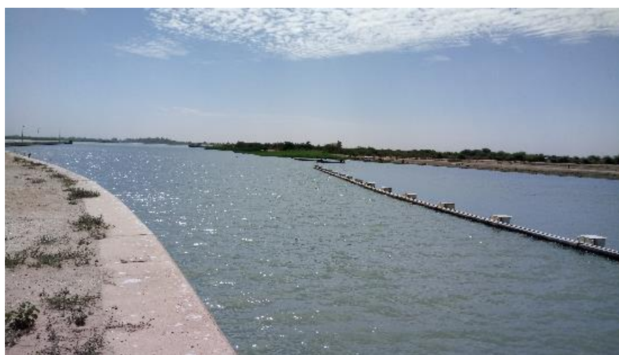
Figure 40 : Le chenal d'approche de l'écluse coté fluvial avec le mur guideau soutenant le musoir à gauche et la lisse de guidage des bateaux à droite
