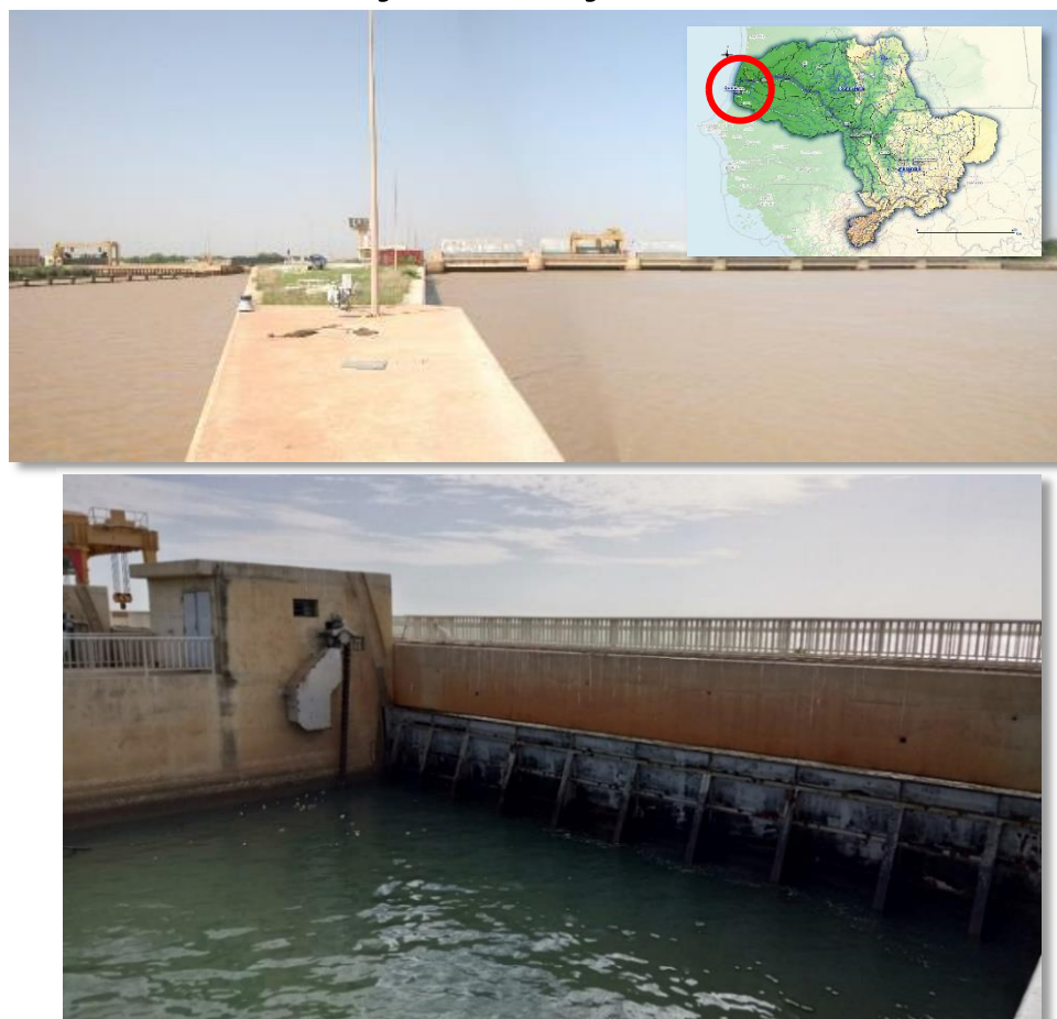
Figure 4 : Le barrage de Diama
