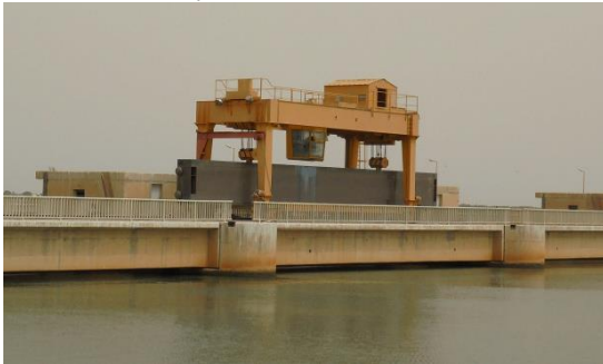
Vue détaillée du portique de manœuvre d'un élément de batardeau amont en cours de mise en place
