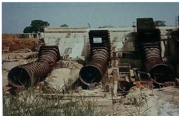
Prises usinières en cours de montage (sur chantier)
