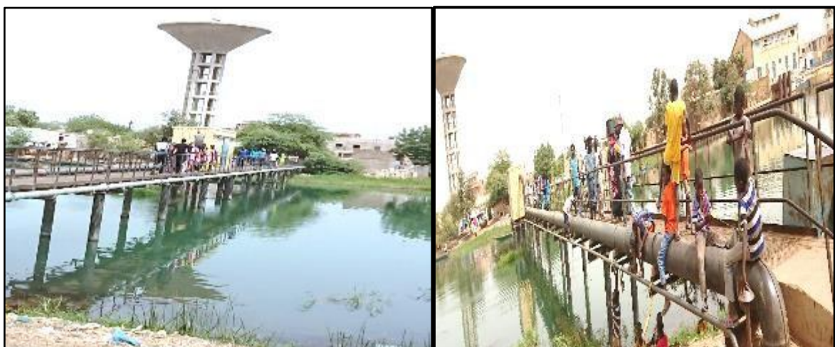
Photo 11 : Usage de l'ouvrage de traversée de la Taouey par les élèves
