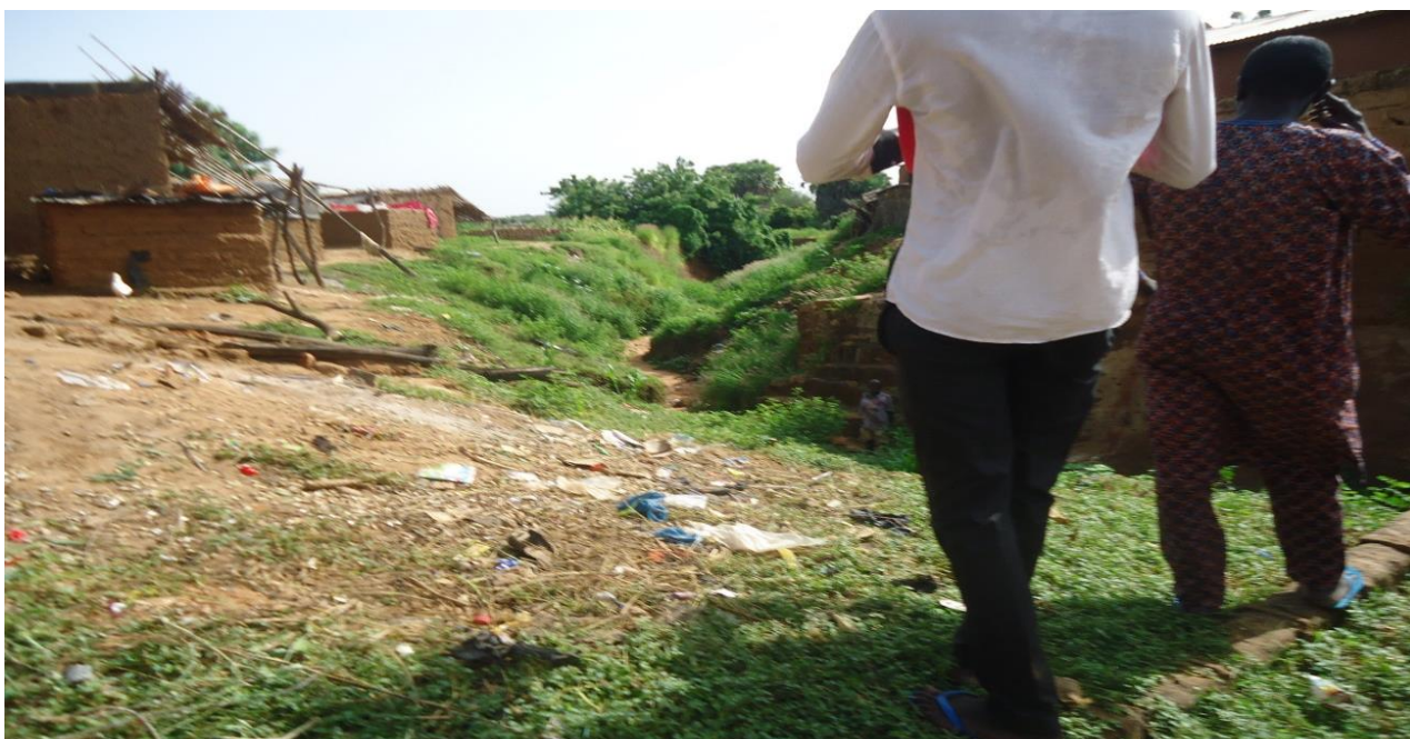
Figure 33 : Menace de l'érosion sur les infrastructures humaines à Kegnou (commune de Hawa Dembaya cercle de Kayes)
