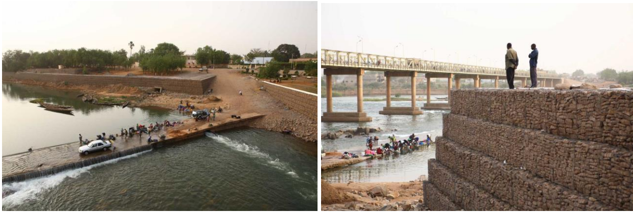
Figure 24 : Vues longitudinales et de faces partielles des travaux de restauration réalisés par l'OMVS (source OMVS)
