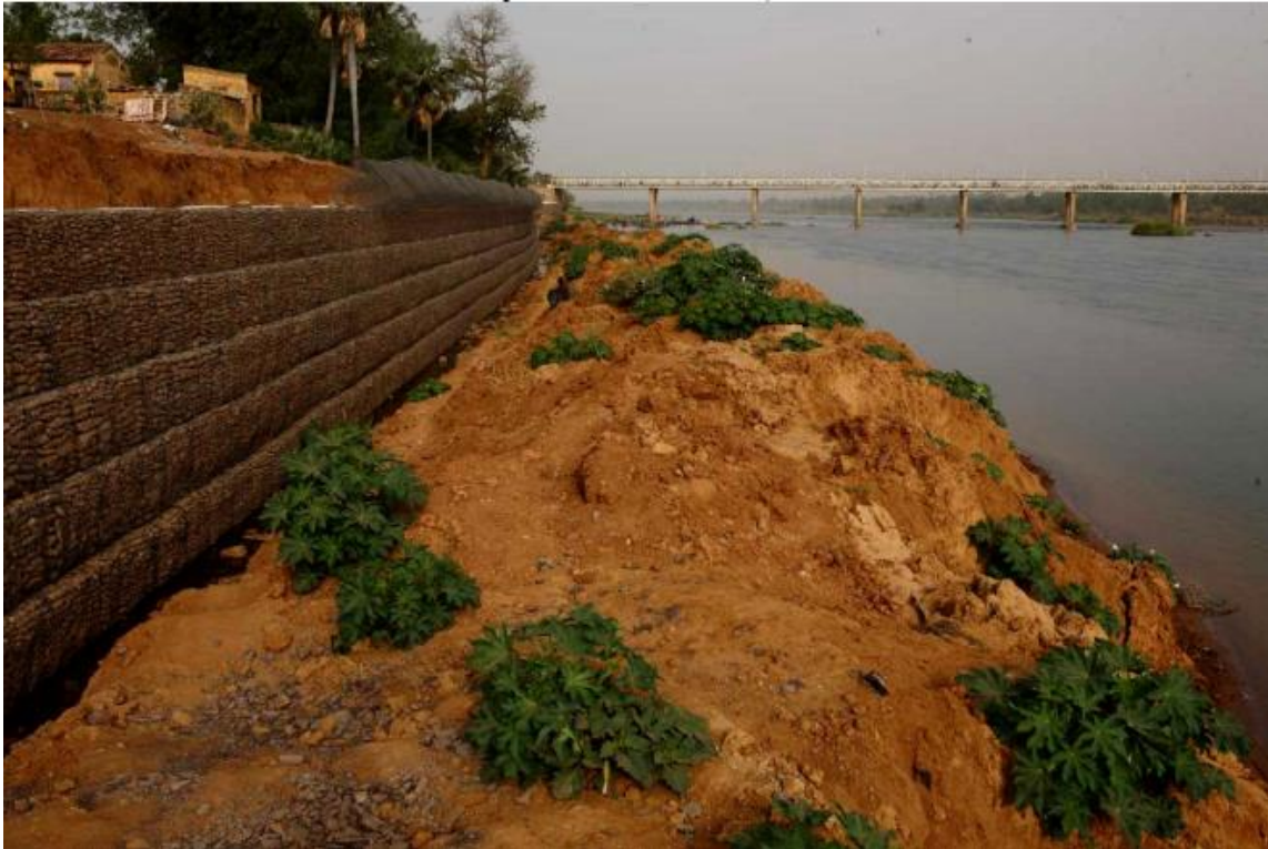
Figure 23: Vue longitudinale partielle du chantier des travaux de restauration des zones dégradées (Source OMVS)
