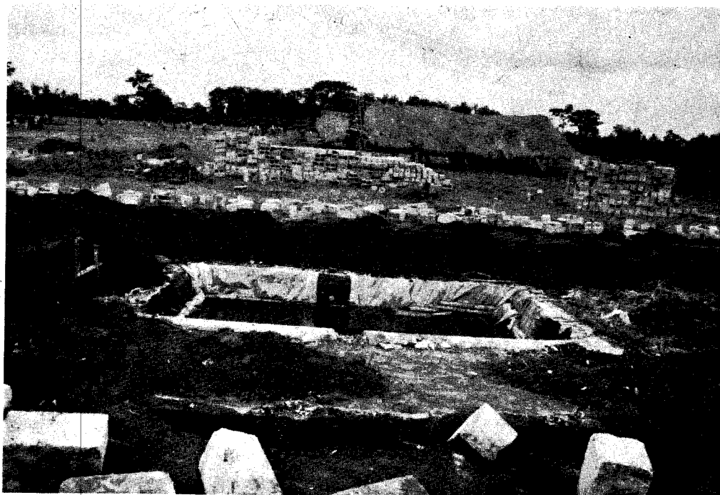
Le Botswana et son impluvium n'existent plus . Ils se trouvent entourés des fondations d'un nouveau bâtiment du CEG de Dzafi .
