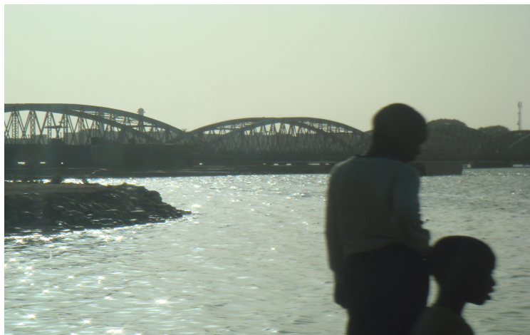
Photo 2: Pont Faidherbe de Saint-Louis
