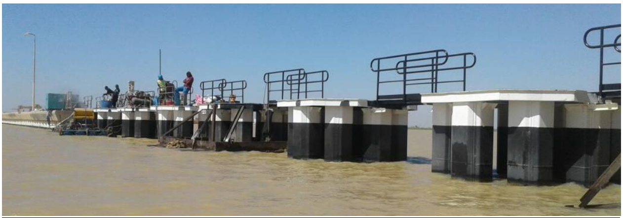
Réfection de la protection passive du guideau et du duc d'albe amont du barrage de Diama
