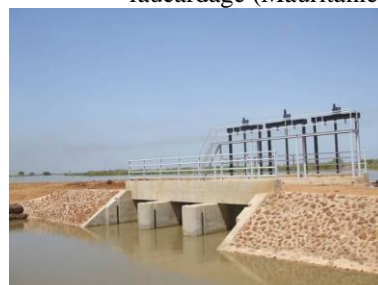
Canal de Krankaye avec l'ouvrage de franchissement (Sénégal)
