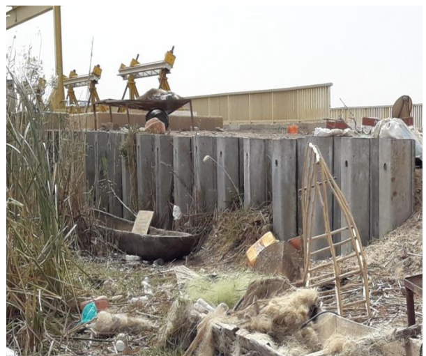
Rideau de palplanches amont RD
