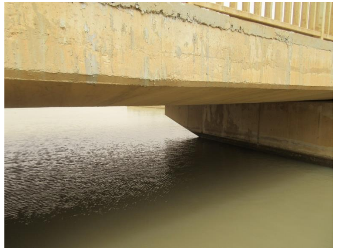
Vue de la dalle de la travée côté Diama
