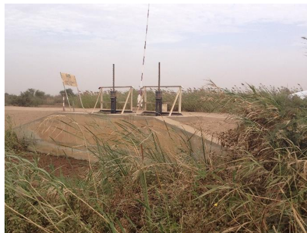
Vue d'un ouvrage de type cadre fermé (Gouère, depuis l'aval)
