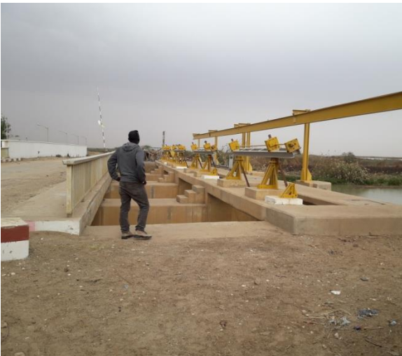
Vue de l'amont de l'ouvrage depuis la RG
