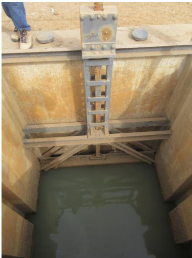
Chambre de vanne. Le béton est en très bon état.
