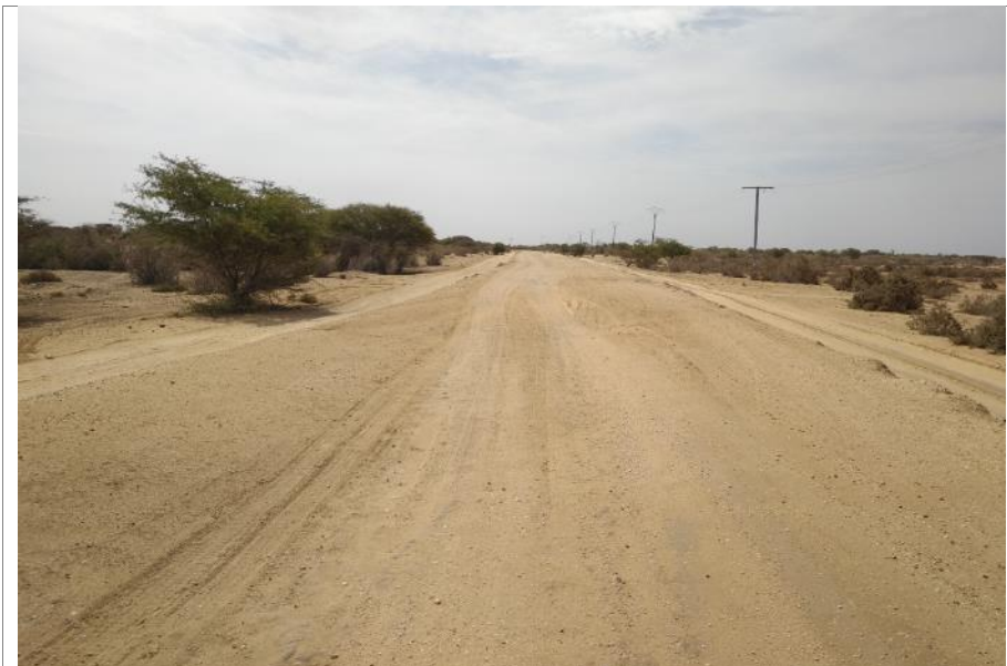
Couche de roulement en banco coquillé dégradée
