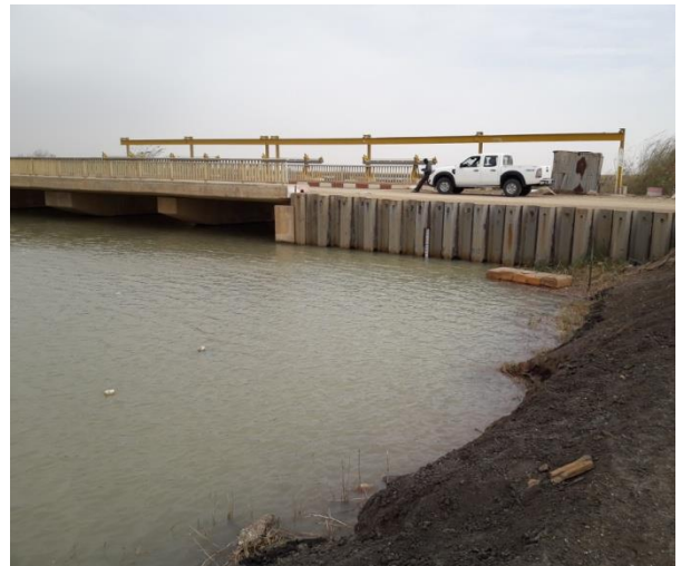
L'ouvrage vu depuis l'aval RG
