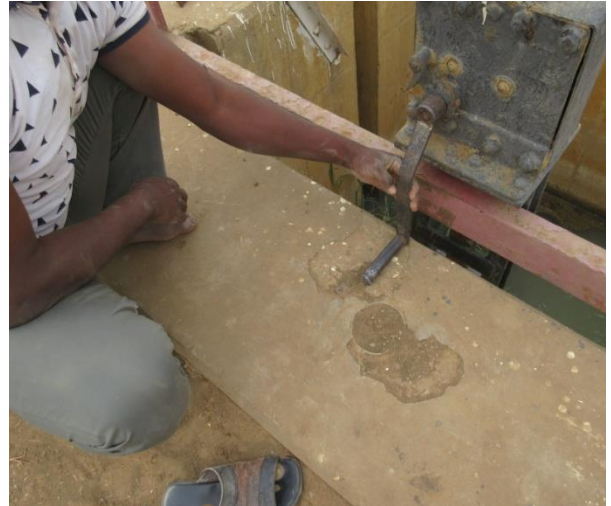
La manivelle touche le béton
