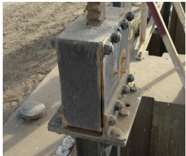
Un boulon est manquant. Capot légèrement entrouvert
