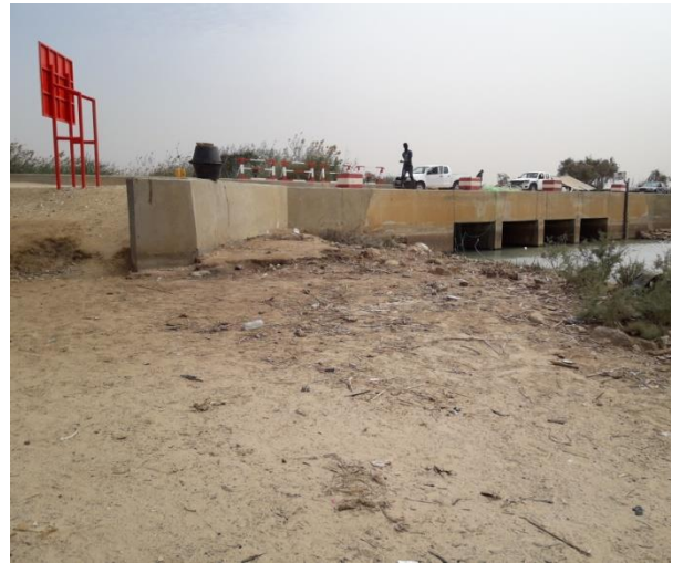
Vue de l'ouvrage depuis l'aval RD
