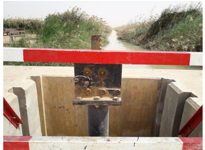
La potence est constituée par un tube métallique
