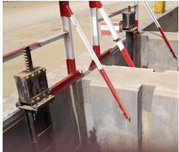
Vue des crics de levage et des fixations des garde-corps
