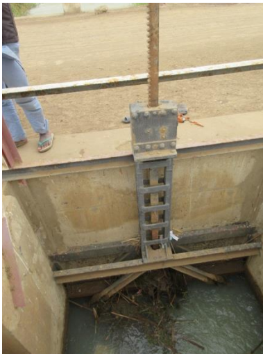
Vue d'une vanne en cours d'ouverture. Le béton est en très bon état.
