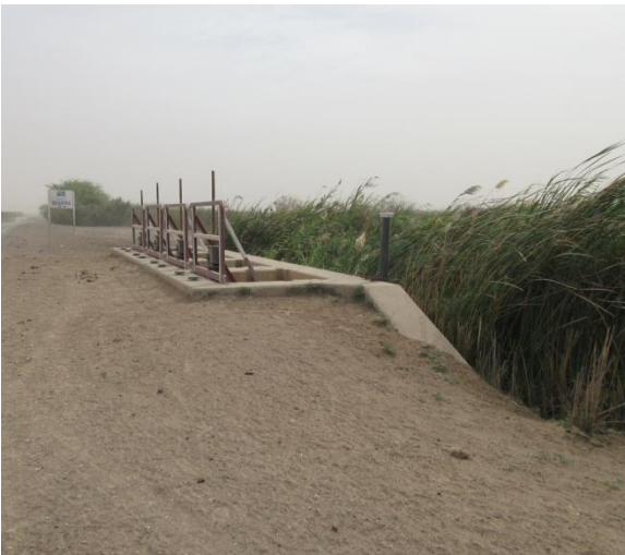
Vue de l'ouvrage depuis l'amont. Le canal est envahi par les typhas. On remarque le limnimètre.
