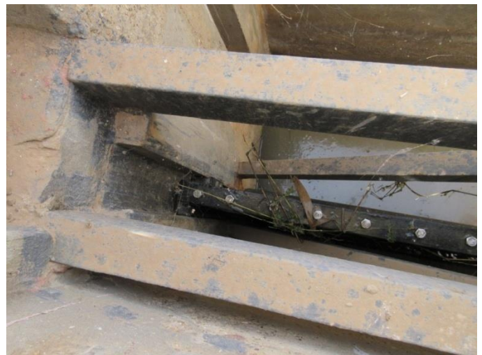
Le plat de serrage est fixé sur la face supérieure du cadre
