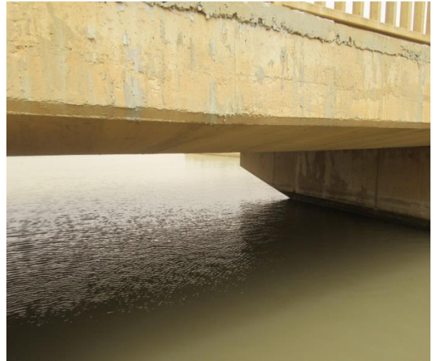
Vue de la dalle de la travée côté Diama
