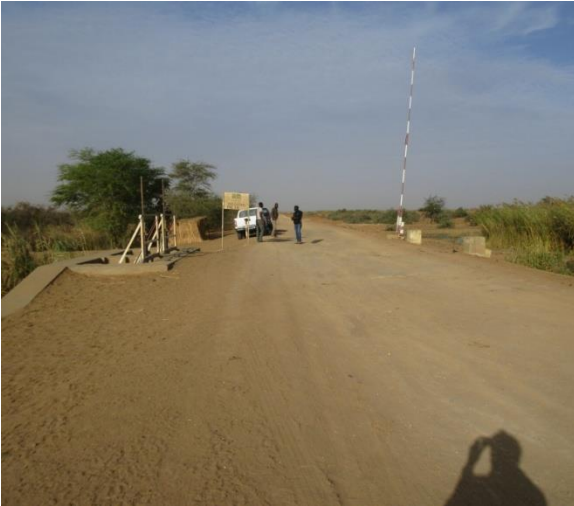
Vue de l'ouvrage en venant de Rosso. La barrière de pluie est fonctionnelle
