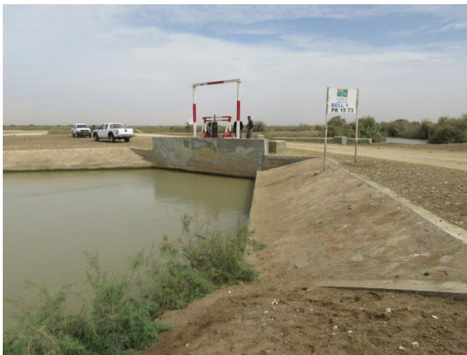
Vue d'un ouvrage du parc de Diawling (Bell 1, vue depuis l'amont)
