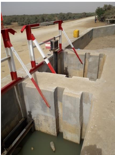
Vue des chambres des vannes
