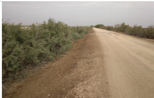
Gabarit de la digue préservé sur les linéaires moins exposés aux vents dominants et en présence de végétation en pied
