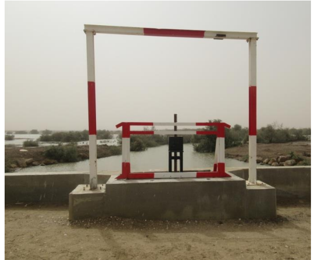
Dispositif de manœuvre de la vanne à simple réducteur à manivelle Louis Feugier de type 0D
