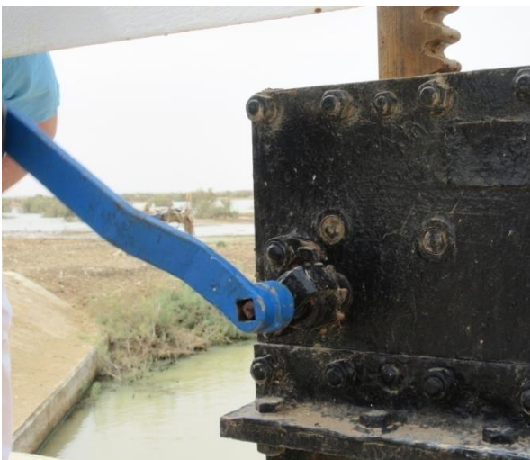
Le cliquet du cric est trop usé pour remplir sa fonction
