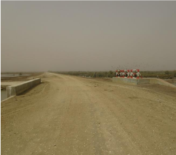
Vue de l'ouvrage en venant de Diamas
