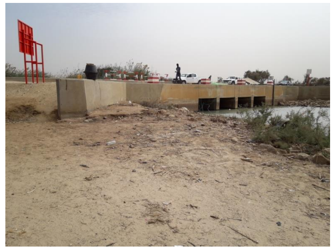
Vue d'un ouvrage du parc de Diawling (Cheyal, vue depuis l'aval)
