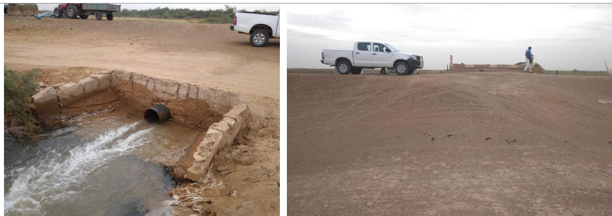
Ouvrages traversant la digue
