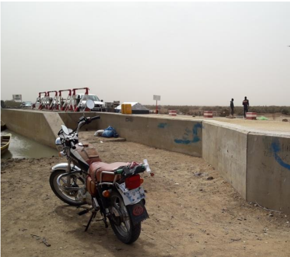
Vue de l'ouvrage depuis l'amont RD
