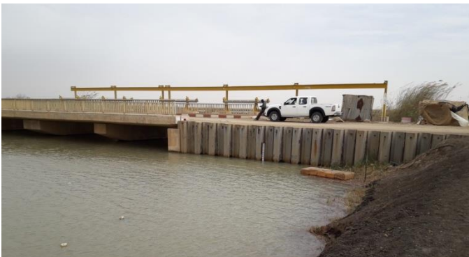
Rideau de palplanches aval RG
