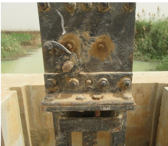
Simple réducteur à manivelle Louis Feugier type 0D. Un des boulons de fixation sur la potence n'est pas en acier inoxydable.
