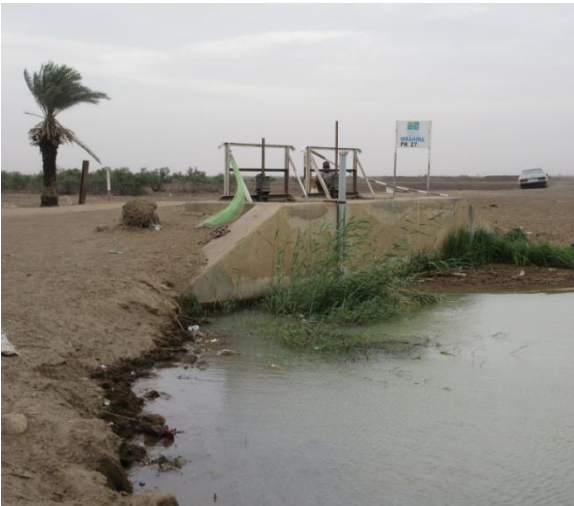
Vue depuis l'amont. On remarque le limnimètre.
