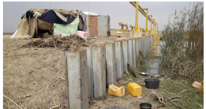
Rideau de palplanches amont RG
