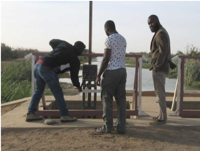
La manivelle affleure la lisse du garde-corps
