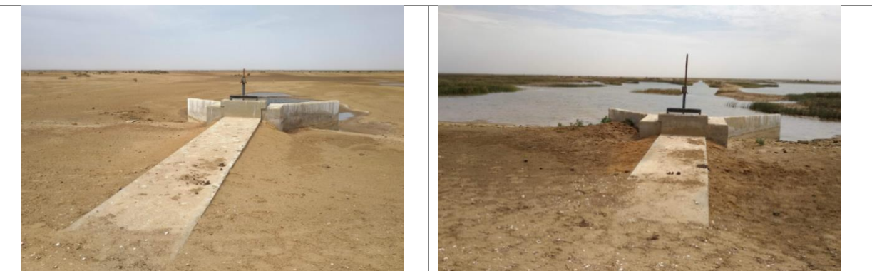
Ouvrage traversant la digue de Bell au Pk 2,650
