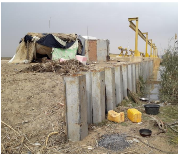
Rideau de palplanches amont RG
