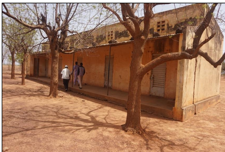
Figure 8 : Service Génie Rural du Cercle de Bafoulabe, Mission de terrain au Mali.
