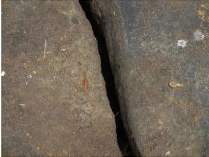
Figure 5-83 : Fente dans la dolérite au niveau des points WP 2 et WP 3 du site 17 (source : Fichtner)
