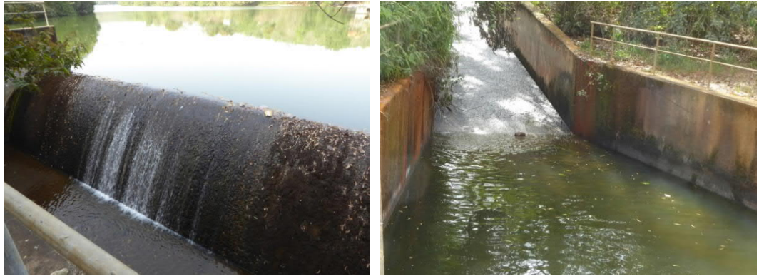
Figure 5-3 : Déversoir et canal en béton (source : Fichtner)
