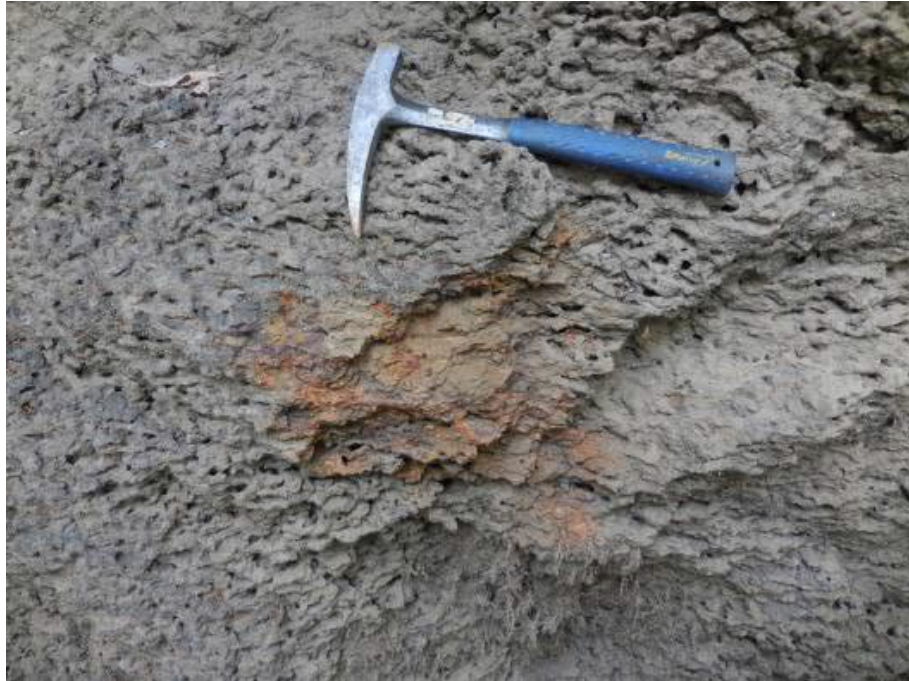
Figure 5-58 : Altération de type « sac de laine » sur le granite de la berge concave à l’aval (source : Fichtner)
