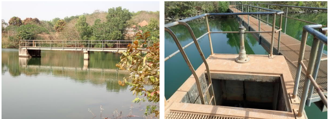
Figure 5-2 : Passerelle au niveau de l'ouvrage de prise d'eau (source : Fichtner)
