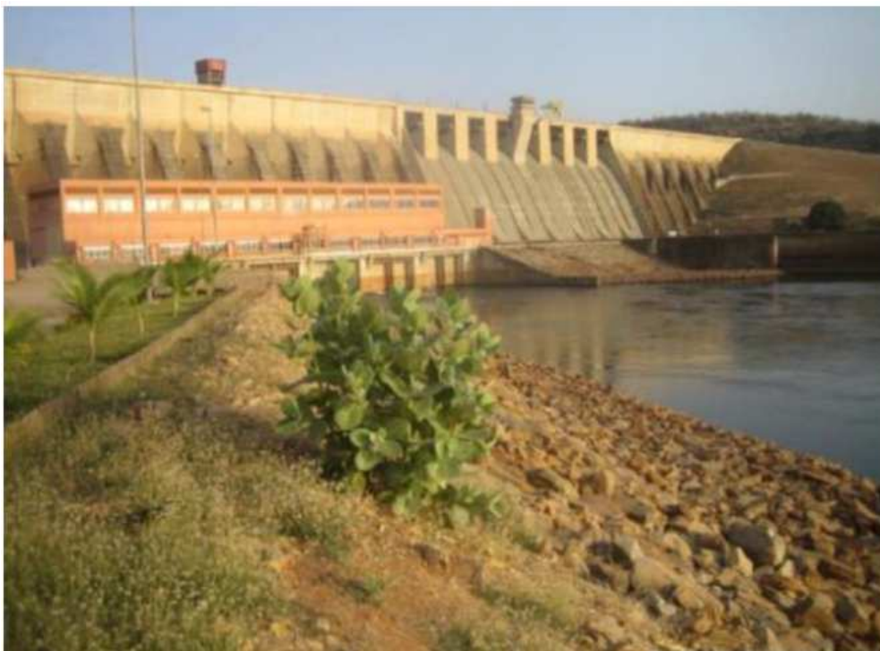
Figure 4 : Le barrage de Manantali
