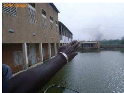
Photos 18 et 19 : école inondée dans la banlieue de Dakar
