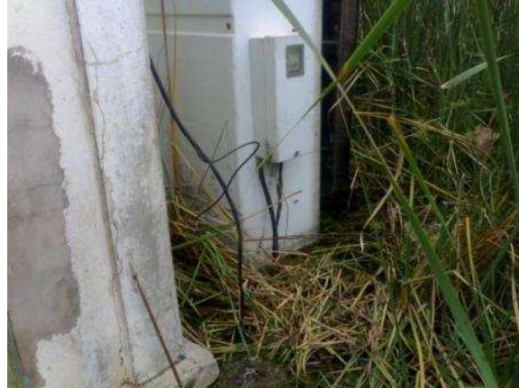
Photos 8 et 9 : à gauche un poste électrique et à droite un transformateur envahis par les eaux
