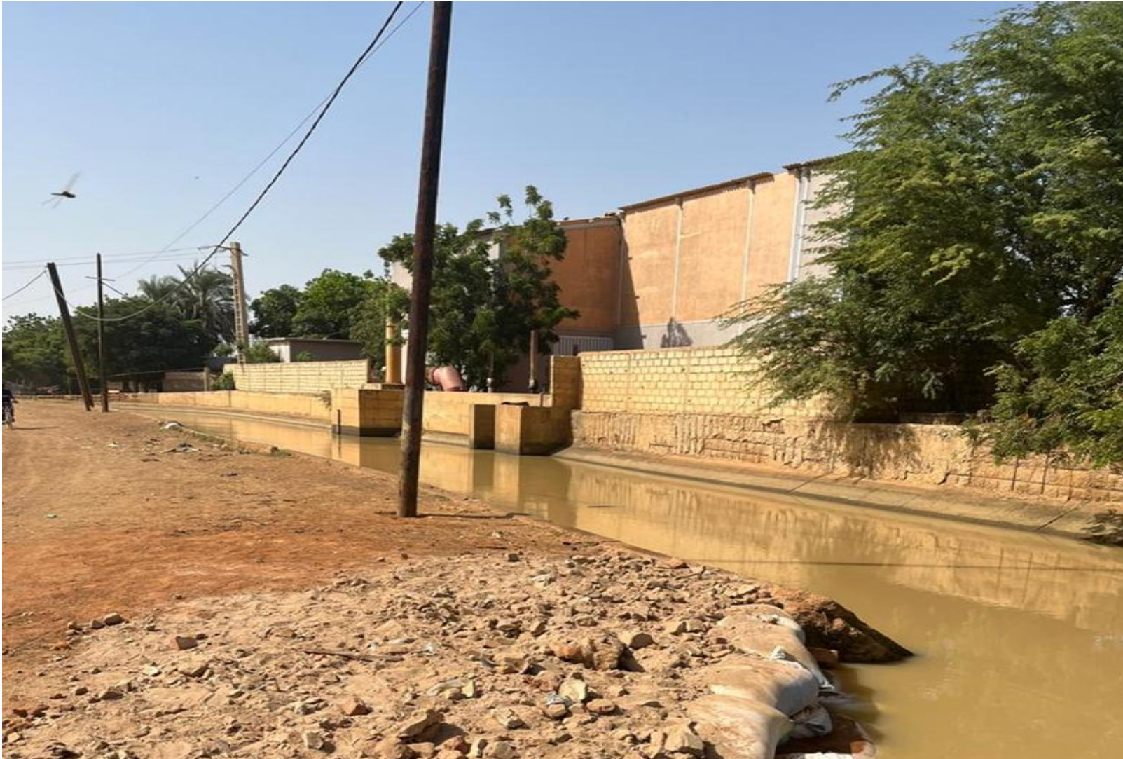
Vue de la station de pompage
