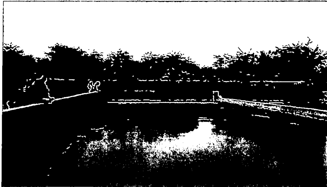
Figure n°6 : Vue du bassin de 1200 m3 et de ses deux compartiments.
