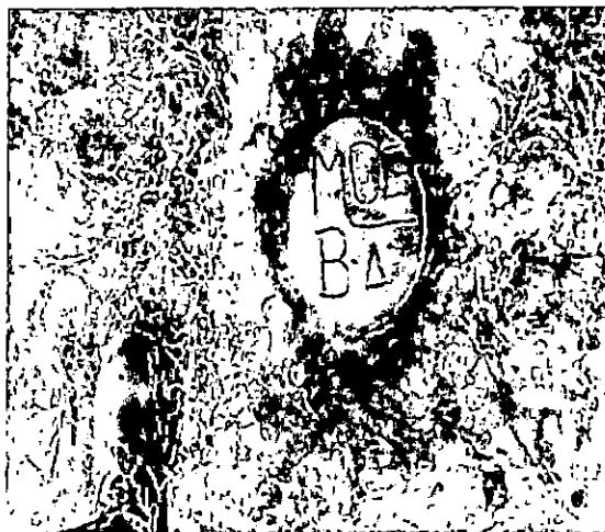
Marquage des bornes topographiques cimentées (Borne B4)
