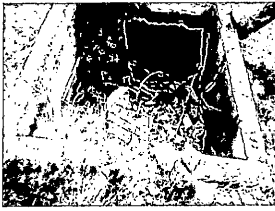
Regard de vanne inaccessible et mal entretenu
