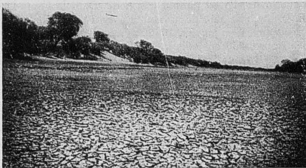
Fig. 2. Le lit du Garak, défluent du Sénégal, en juillet 1954. Ce défluent relie le fleuve à la cuvette de Guivo, proche du R'Kiz. Le lit est formé par les limons argileux de décantation, qui se déposent lors de la décrue, la pente étant insignifiante par suite de l'écoulement dirigé tantôt dans un sens tantôt dans l'autre. Ces dépôts sont découpés par des fentes de dessiccation. A gauche, la rive concave entaillée dans les dunes pré-ouliennes est envahie par les sables remis en marche au cours de la saison sèche.
