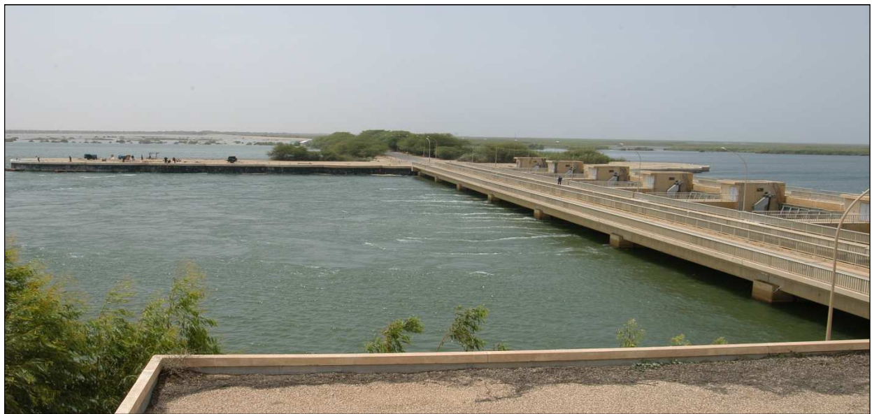
Vue d'ensemble du côté aval de l'évacuateur de crue et de la digue de bouchure du barrage de Diama
