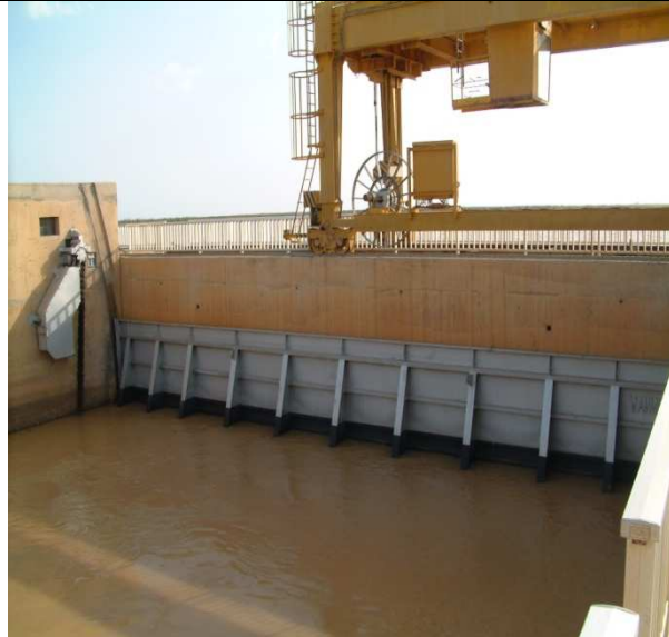
Une vanne segment de l'évacuateur de crue Position fermée - Vue du côté aval
