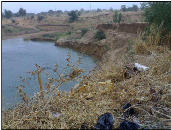
Fig.5. Berge dégradée du fleuve Sénégal – Zone de Kayes (Photo A. Cissé, 2007)
