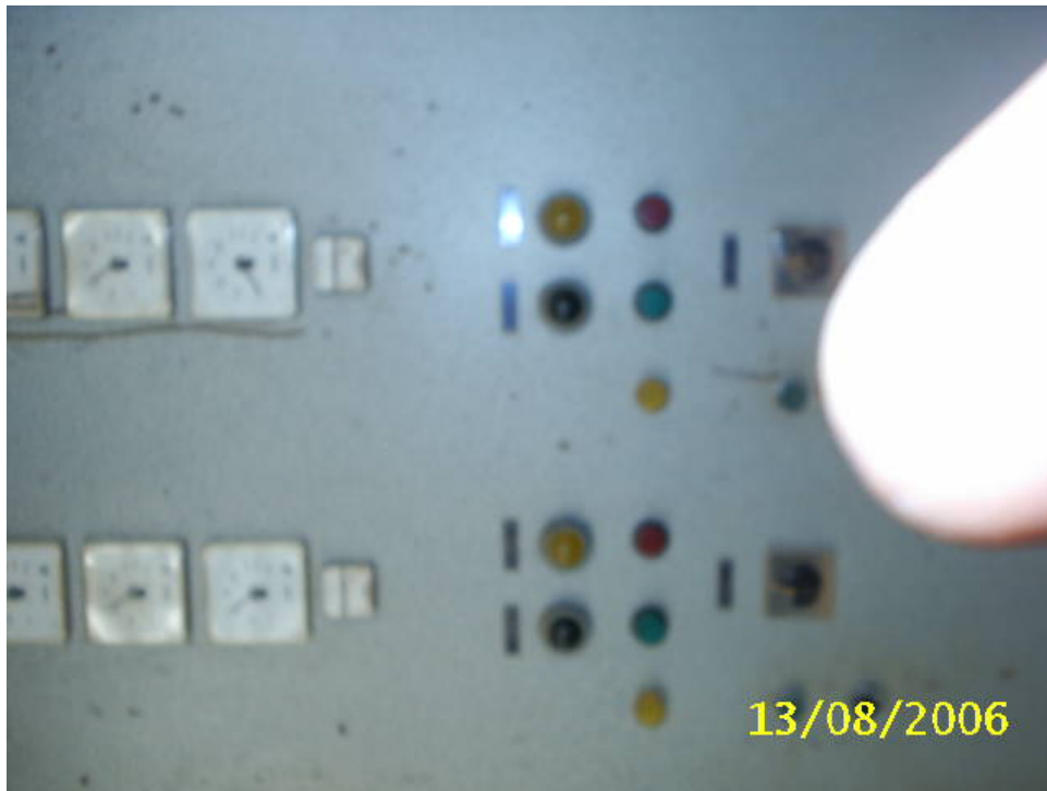
Face avant de l'armoire des électropompes avec les appareils de mesure et les voyants
