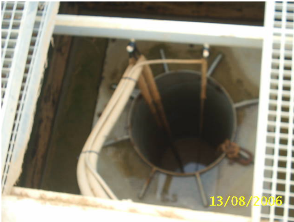
Loge d'une électropompe
