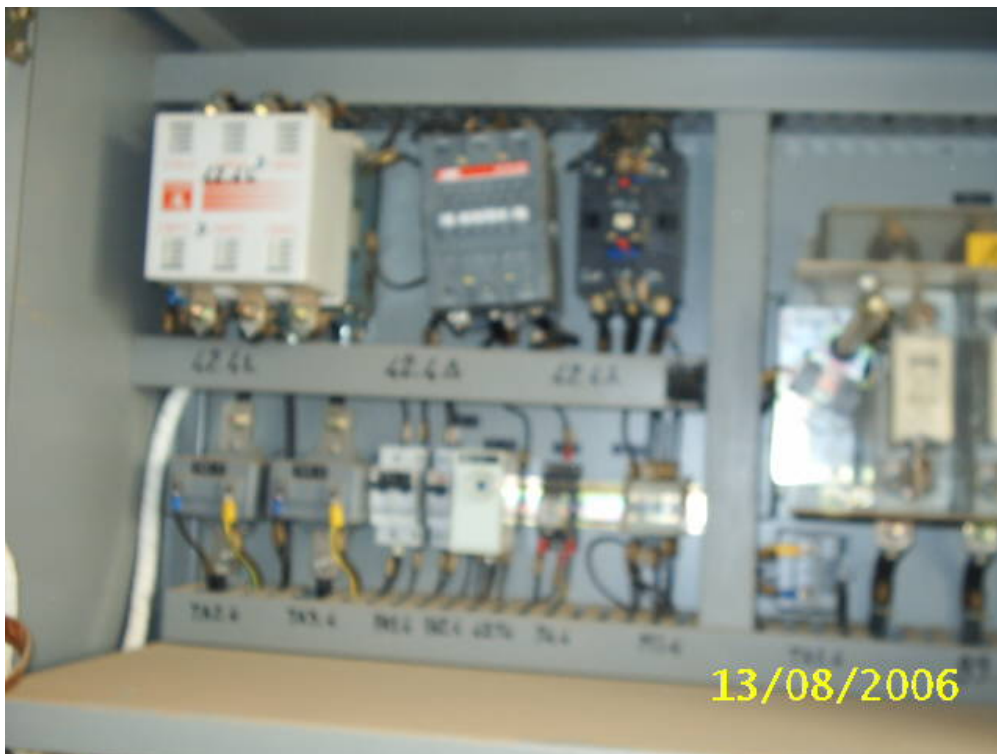
Contacteur changé d'une cellule par un autre de marque ABB
