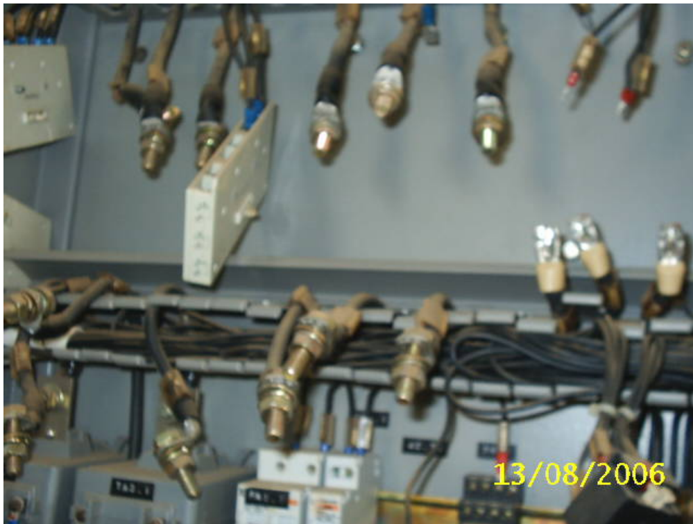
Cellule défigurée pour dépanner les autres cellules
