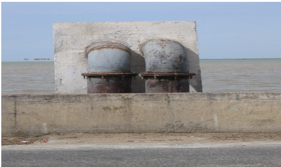
Photo 6 : Rejet des eaux pluviales stagnantes à partir de la station de pompage réhabilitée de Diawlingue (Sor Nord). Photo (M. Sall, novembre 2005)
