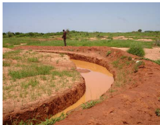
Photo 4 : Demi-lune pour retenir les eaux de pluie
