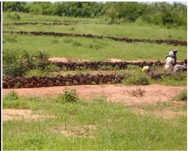
Photo 6 : Ouvrage en progression
