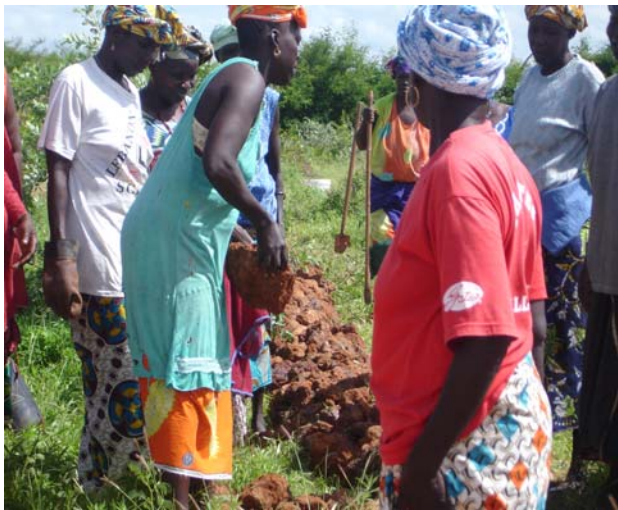
Photo 5 : Femmes construisant un cordon pierreux anti-érosif
