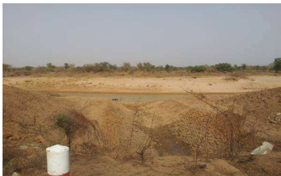
Dépôt de déblais à Ounaré (Sénégal)
