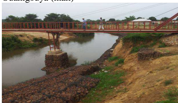
Passerelle et gabionnage à Dounet (guinée)
