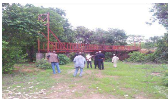
Passerelle inaccessible à Médinatou Salam (Guinée)
