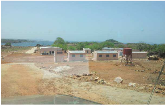
Vue d'ensemble du débarcadère et du centre de pêche de Manantali (Mali)
