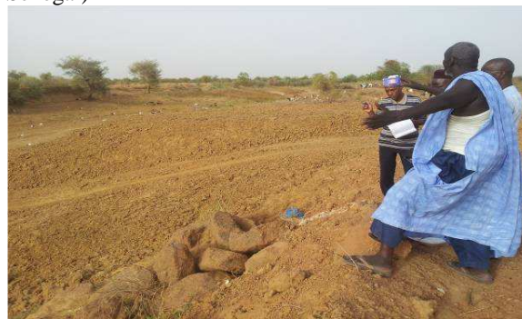
Dépôt de déblais à Orkadiéré (Sénégal)
