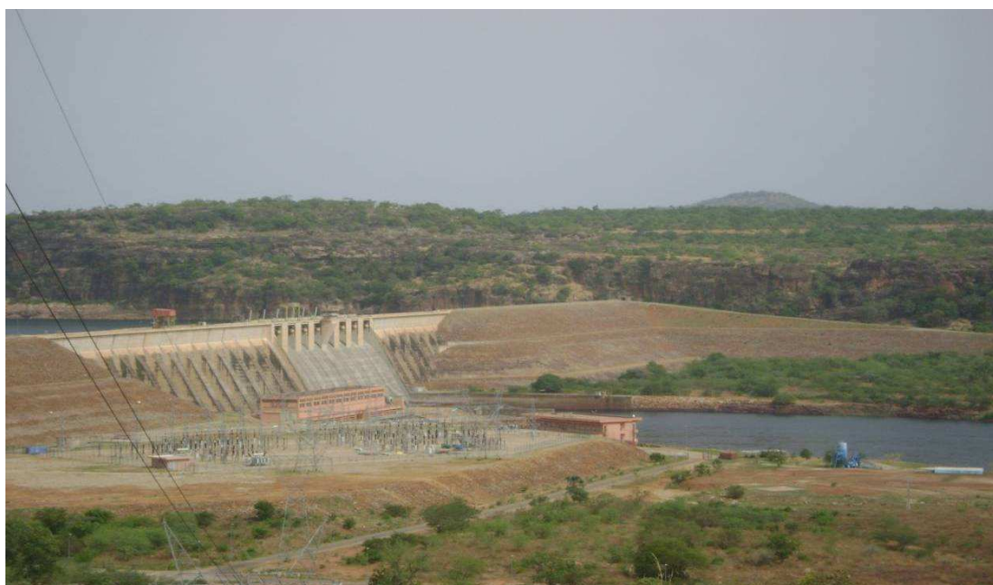
Photo 4 : Barrage et centrale hydroélectrique de Manantali avec en premier plan le poste de départ et les pylônes du réseau Est vers Bamako
