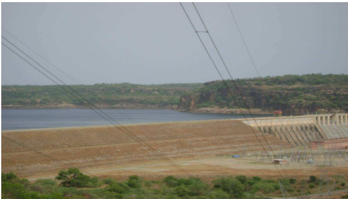
Photo 3 : Le barrage et la centrale hydroélectrique de Manantali, premiers ouvrages dans le programme d'exploitation du potentiel du bassin du fleuve Sénégal
