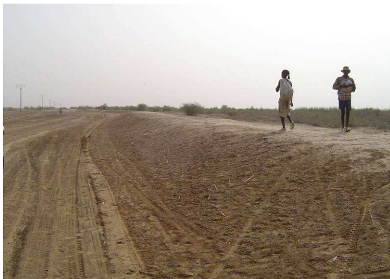
Photo 8 : Digue en rive gauche en aval immédiat de Rosso
