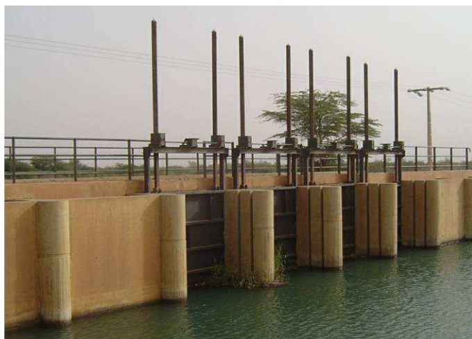
Photo 9 : Exemple d'ouvrage de franchissement hydraulique
