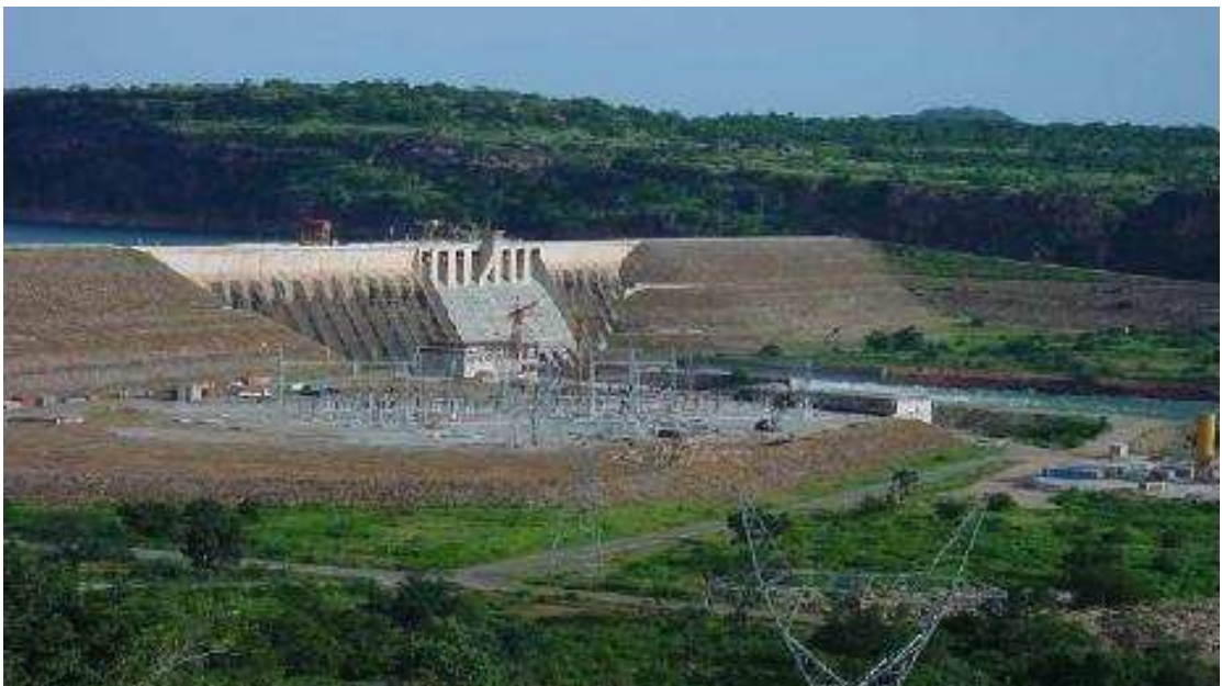
Photo 1 : Le barrage de Manantali vu de la route d'accès
