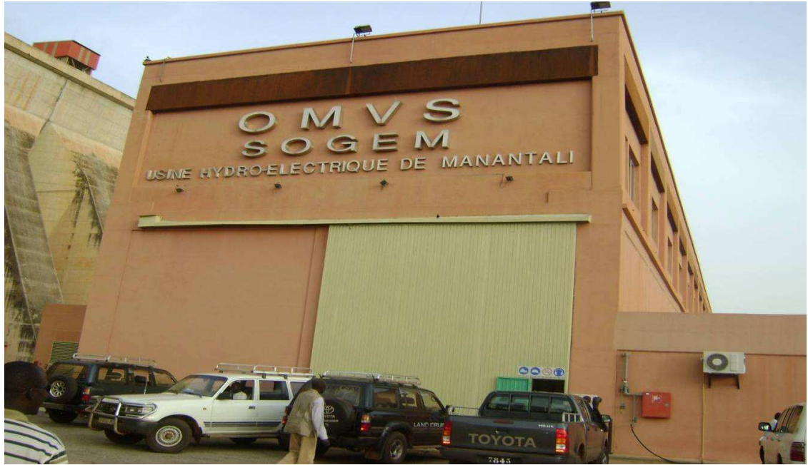
Photo 6 : Vue extérieure et entrée du bâtiment abritant la salle des machines de la centrale hydroélectrique de Manantali
