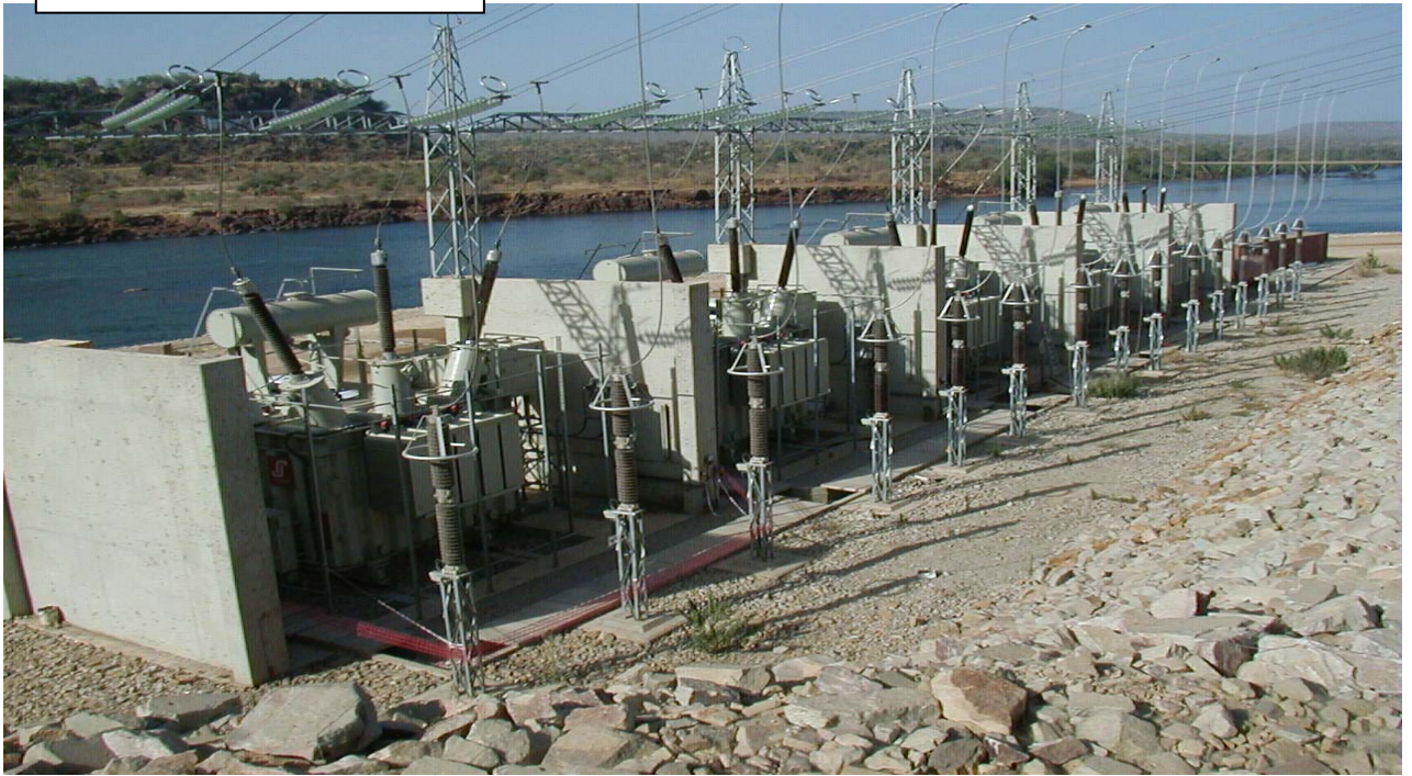
Banc de transformateurs
