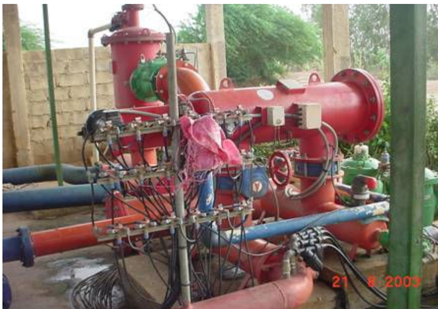
sortie de la station de pompage du système goutte à goutte du périmètre de AON, dans l'extension de Mpurrié
