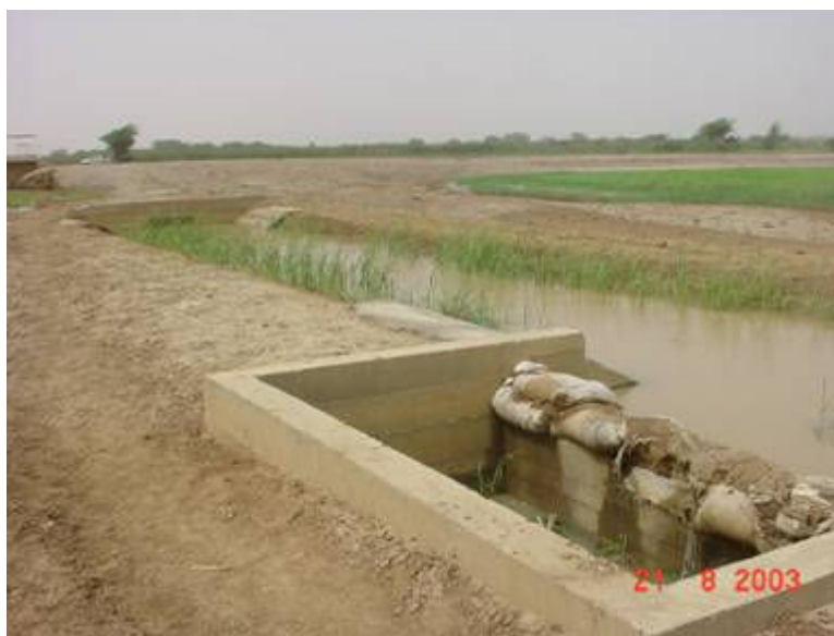
Canal principal de Bellara. Vue d'un rehaussement de la ligne d'eau, par surrelèvement du niveau du déversoir de sécurité au moyen de sacs de terres. Remarquer, en face du déversoir, le faible tirant de la revanche disponible
