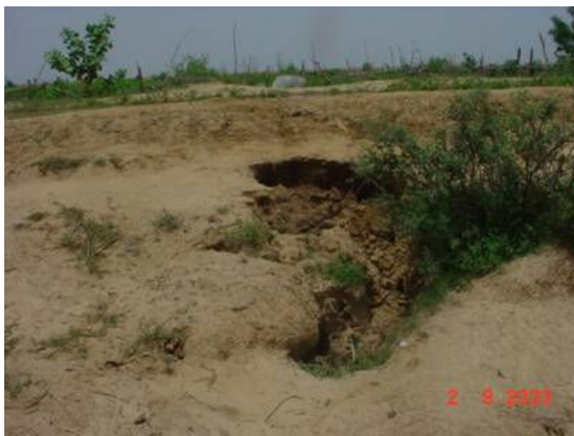
Vue d'un début d'érosion régressive vers le canal principal. Remarquer les terres mouillées dans le ravin, dénotant de la présence de la nappe d'infiltration.
