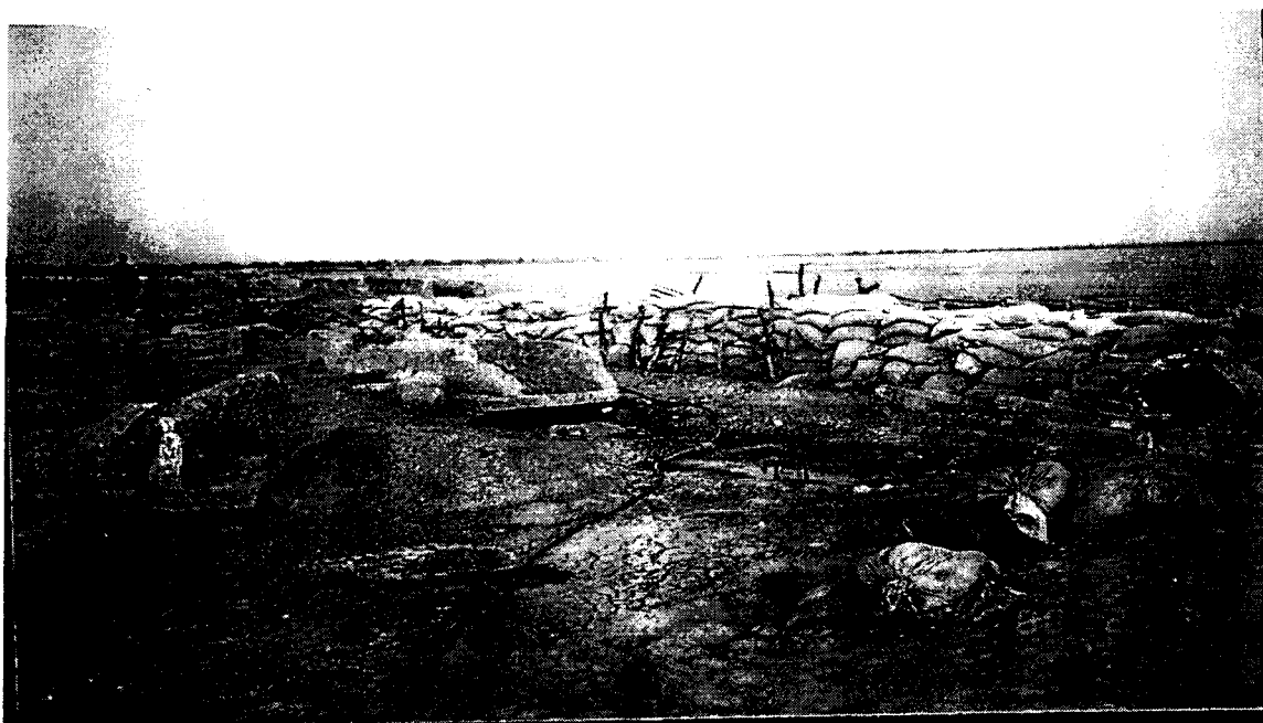
Photo 6 : Rupture de la digue de Darou lors de l'inondation de 1999
